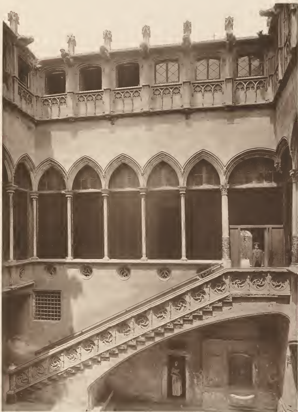
BARCELONA HOF IM GERICHTSGEBAEUDE STIL: GOTHISCH ERBAUT 1305
