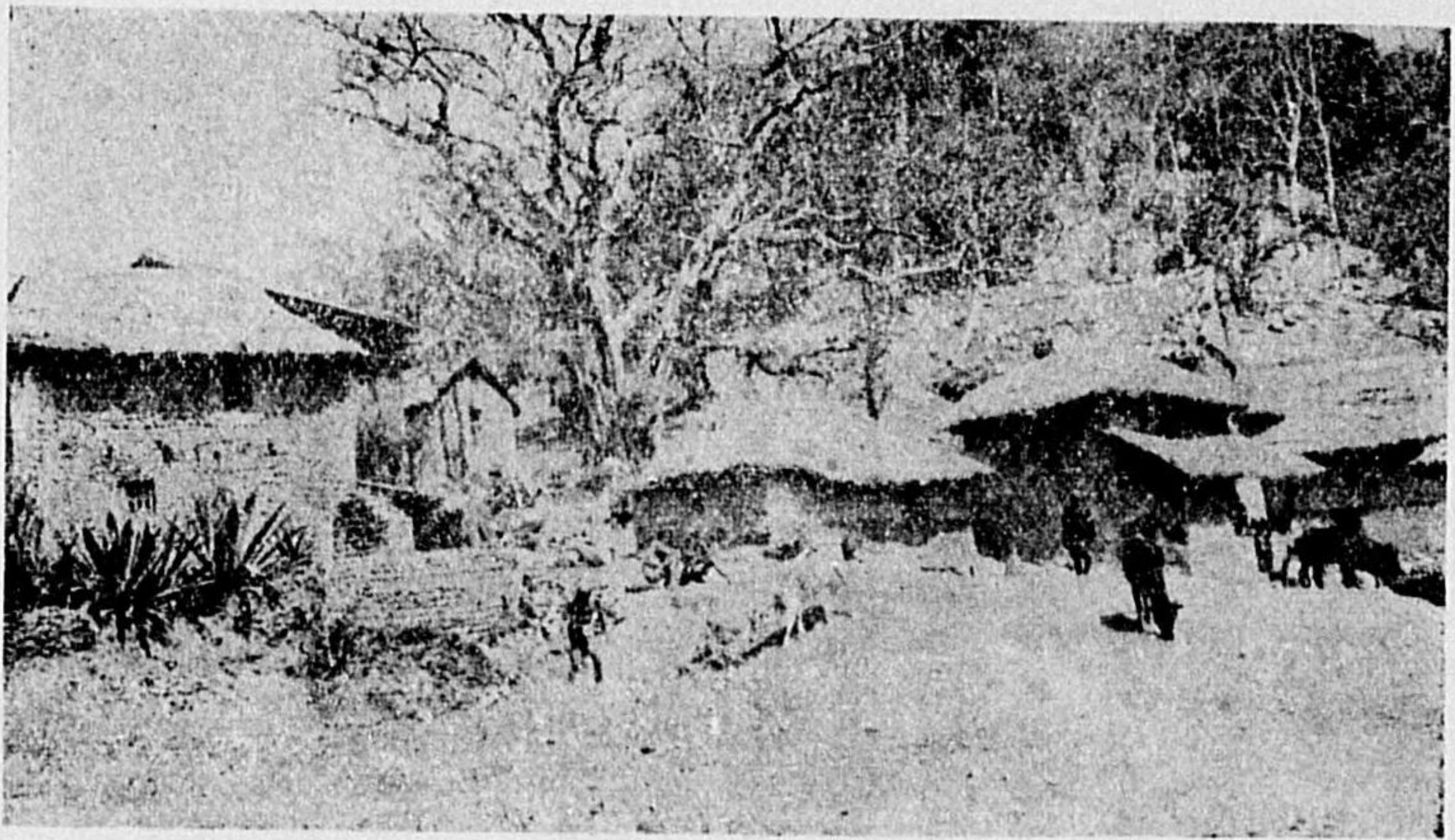
上。スワヤンプ丘麓の村落 （昭和十一年三月二十日） 下。ポドナート村の農家 （昭和十一年三月十八日） 上圖中央の農家と下圖階下は、半分から下が例の代赭色に塗つてあり、他の部分は白色。下圖の農家はまことに粗末であるが、階下正面には濡椽があり、柱を建て扉がでてゐる。柱もいい加減な自然木だし、すべて上塗がなくて泥のままだから、大して美しくもないし非衛生的であるが、町の家がすべてこの式で並んでゐるのを、私は南印コンジーベラム市の郊外でみたことがある。夫れに比べれば随分ひどいが、割合に面白い造り方である。
