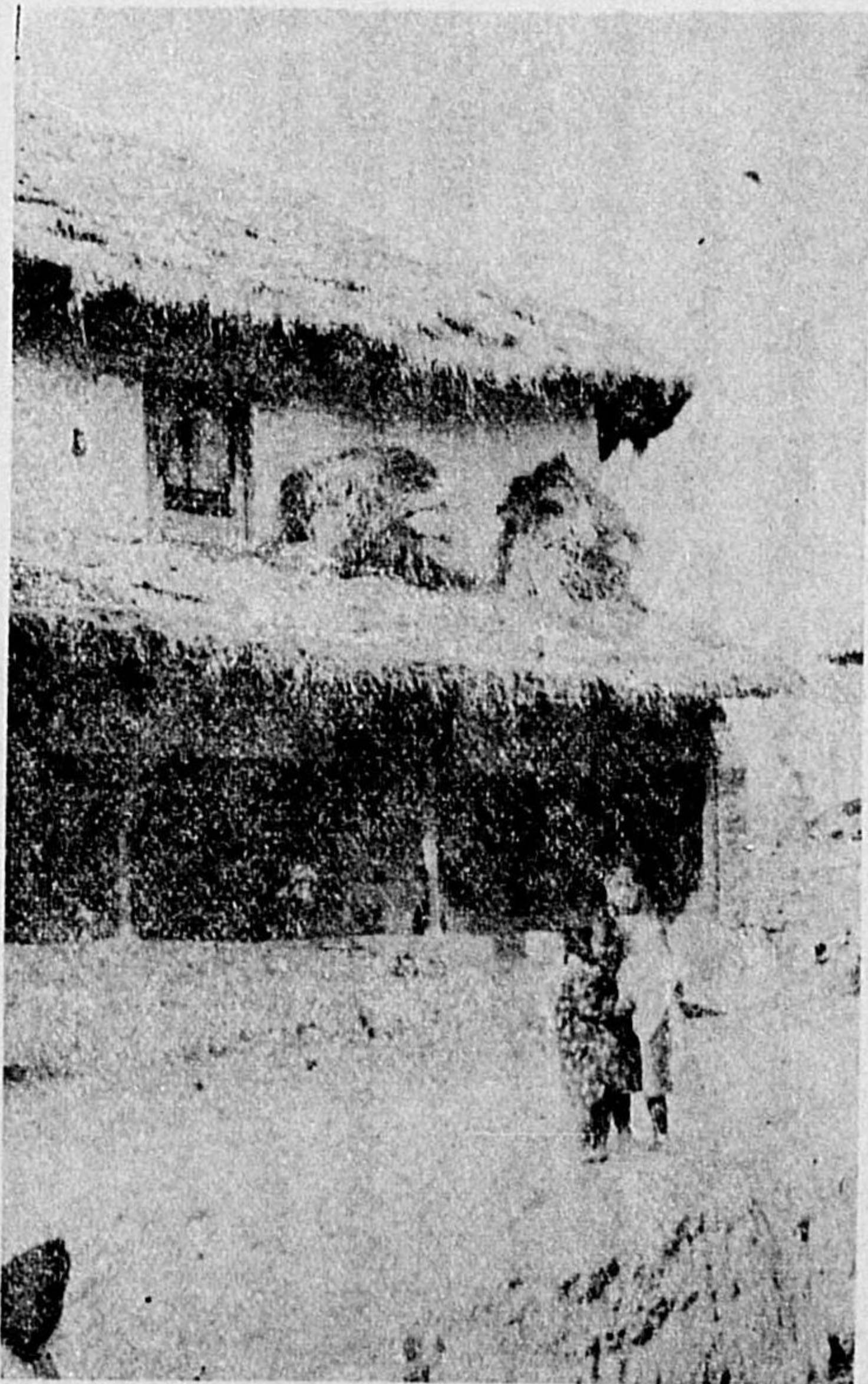
上。スワヤンプ丘麓の村落 （昭和十一年三月二十日） 下。ポドナート村の農家 （昭和十一年三月十八日） 上圖中央の農家と下圖階下は、半分から下が例の代赭色に塗つてあり、他の部分は白色。下圖の農家はまことに粗末であるが、階下正面には濡椽があり、柱を建て扉がでてゐる。柱もいい加減な自然木だし、すべて上塗がなくて泥のままだから、大して美しくもないし非衛生的であるが、町の家がすべてこの式で並んでゐるのを、私は南印コンジーベラム市の郊外でみたことがある。夫れに比べれば随分ひどいが、割合に面白い造り方である。
