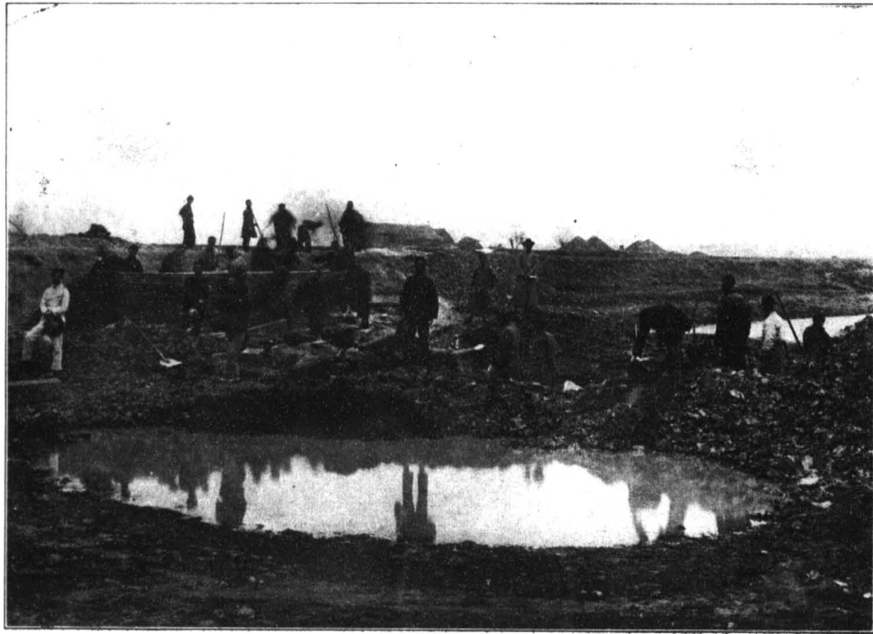
河南第九區築路處潢小線第一橋樑施工事務所雙碑橋施工攝影
