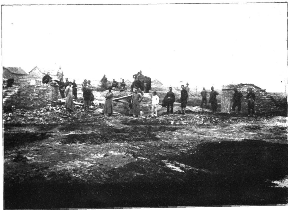
影攝工施橋廟高所務事工施樑橋一第線小潢處路築區九第南河
