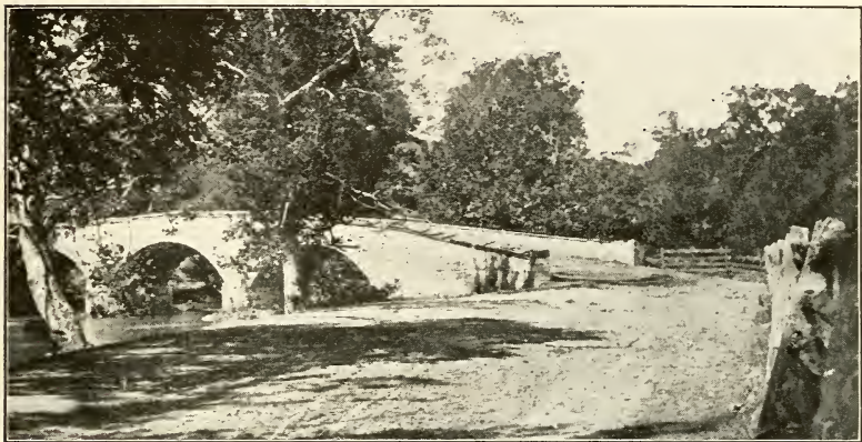
Burnside Bridge, Antietam.
