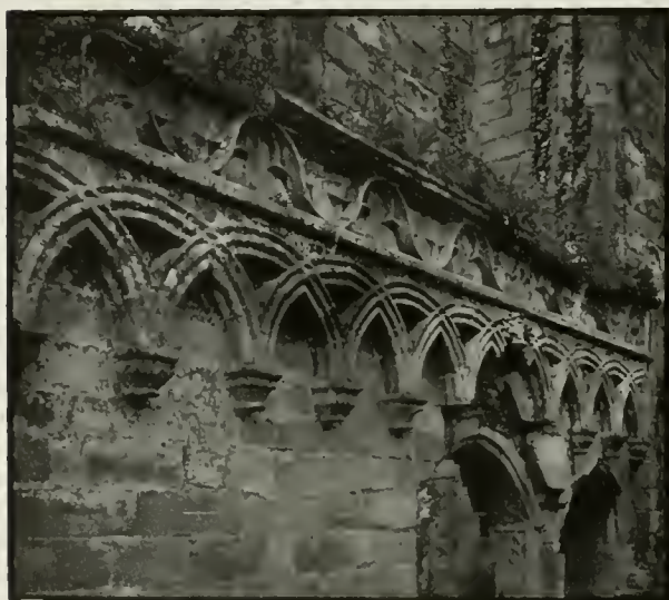
H. E. I. Bolton Priory, Yorkshire
