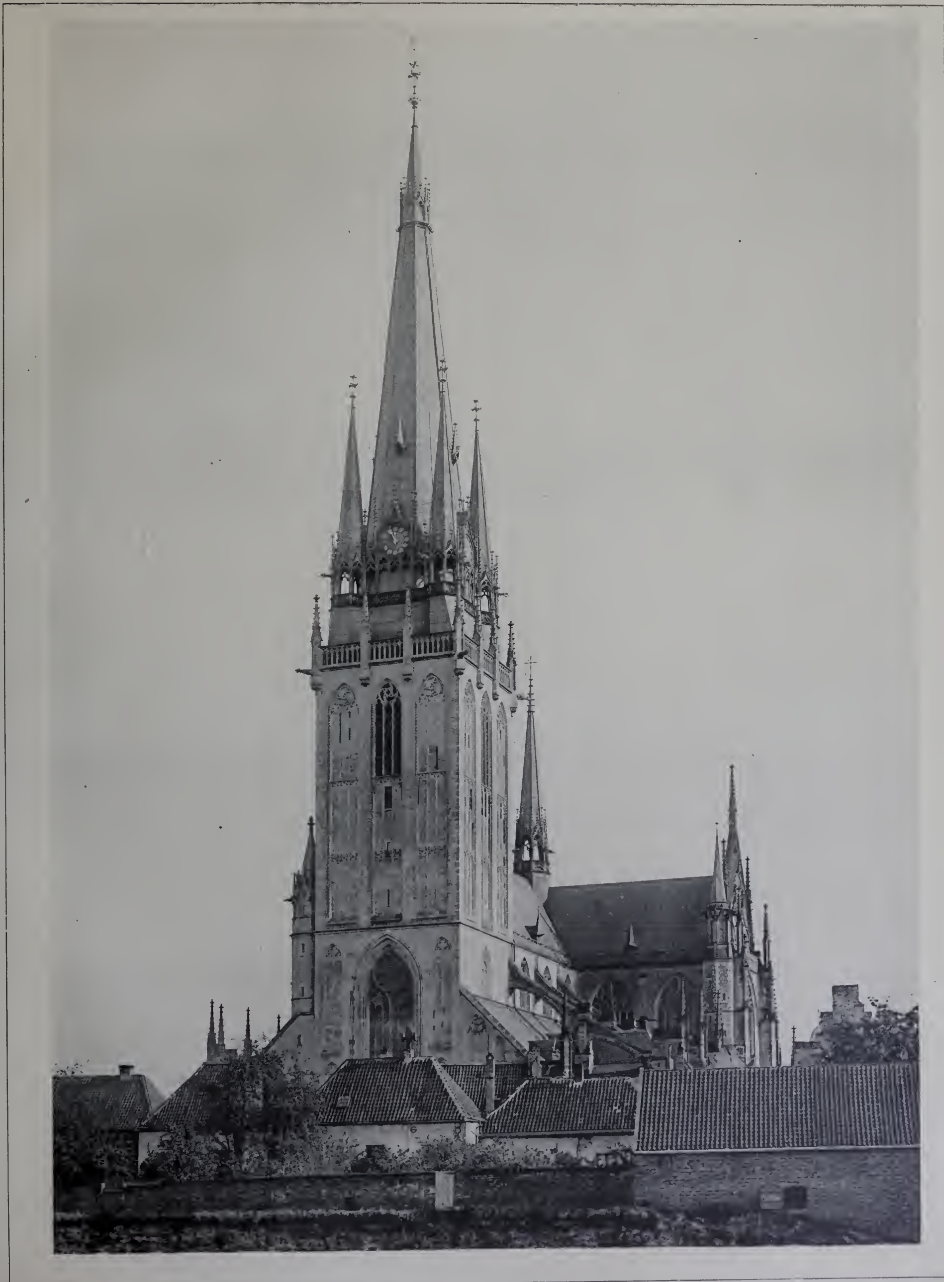
Architekt der Wiederherstellung und Vollendung: F. Adler, Berlin.
