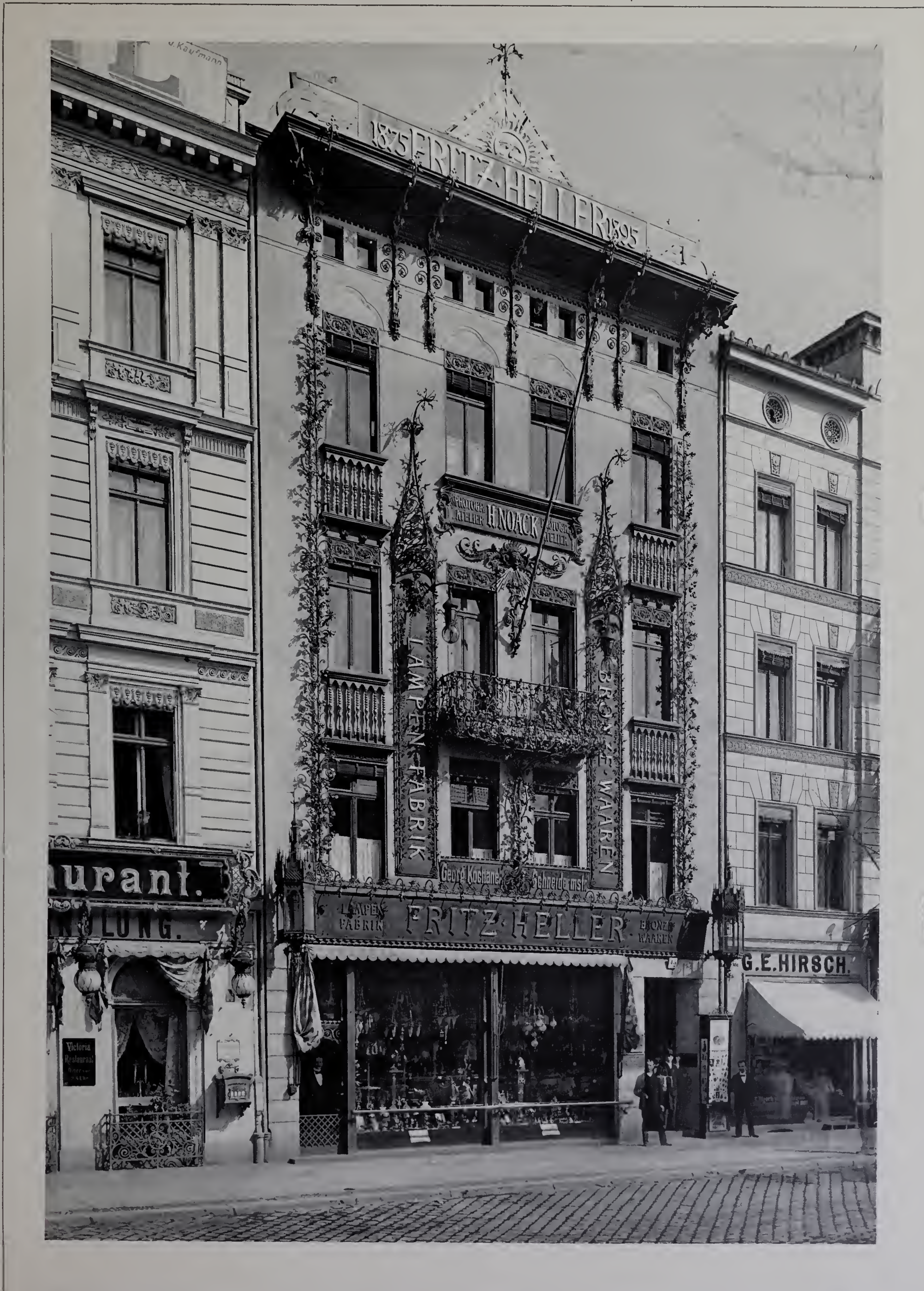
Architekt: H. Jassoy, Charlottenburg.
