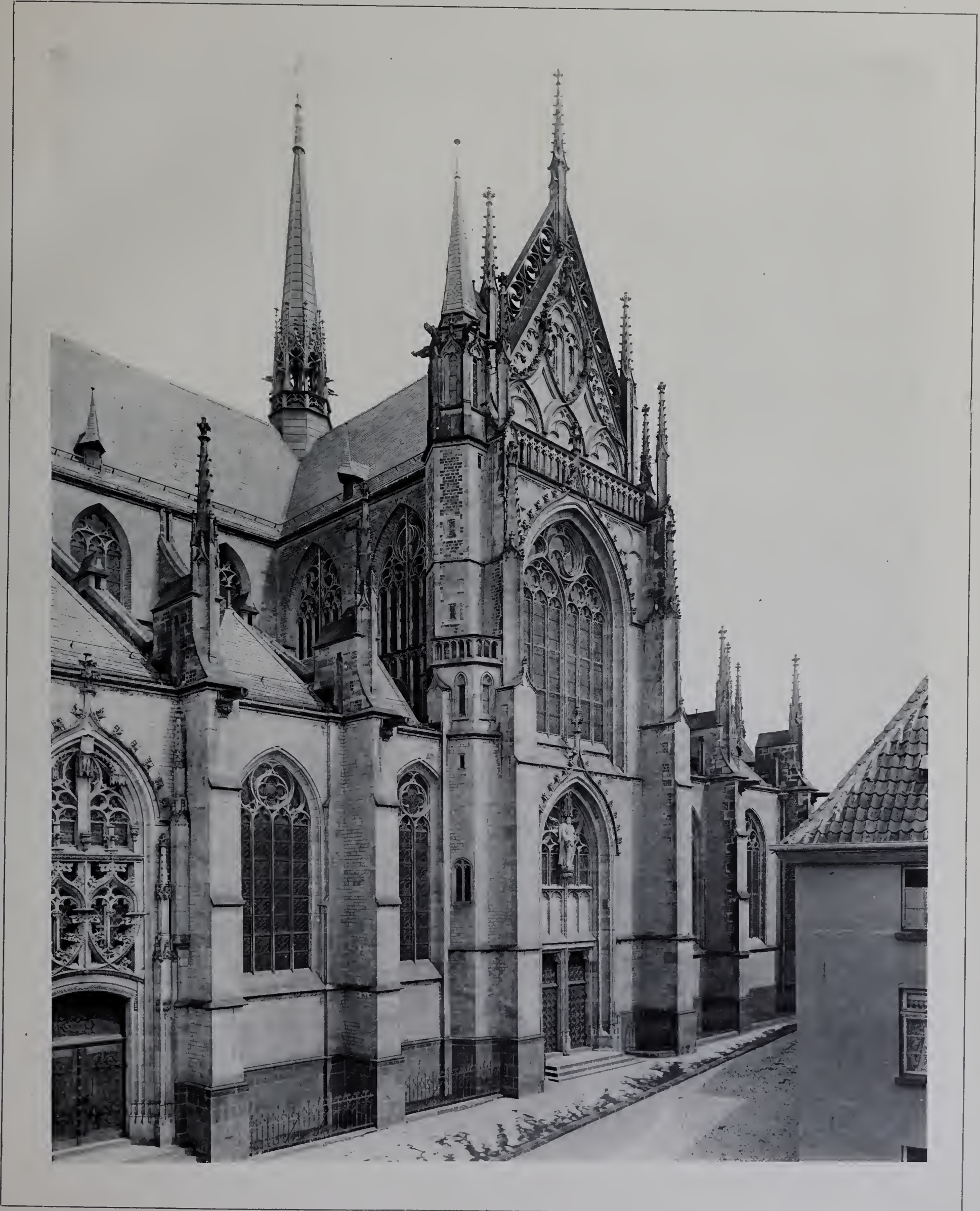
Architekt der Wiederherstellung und Vollendung: F. Adler, Berlin.
