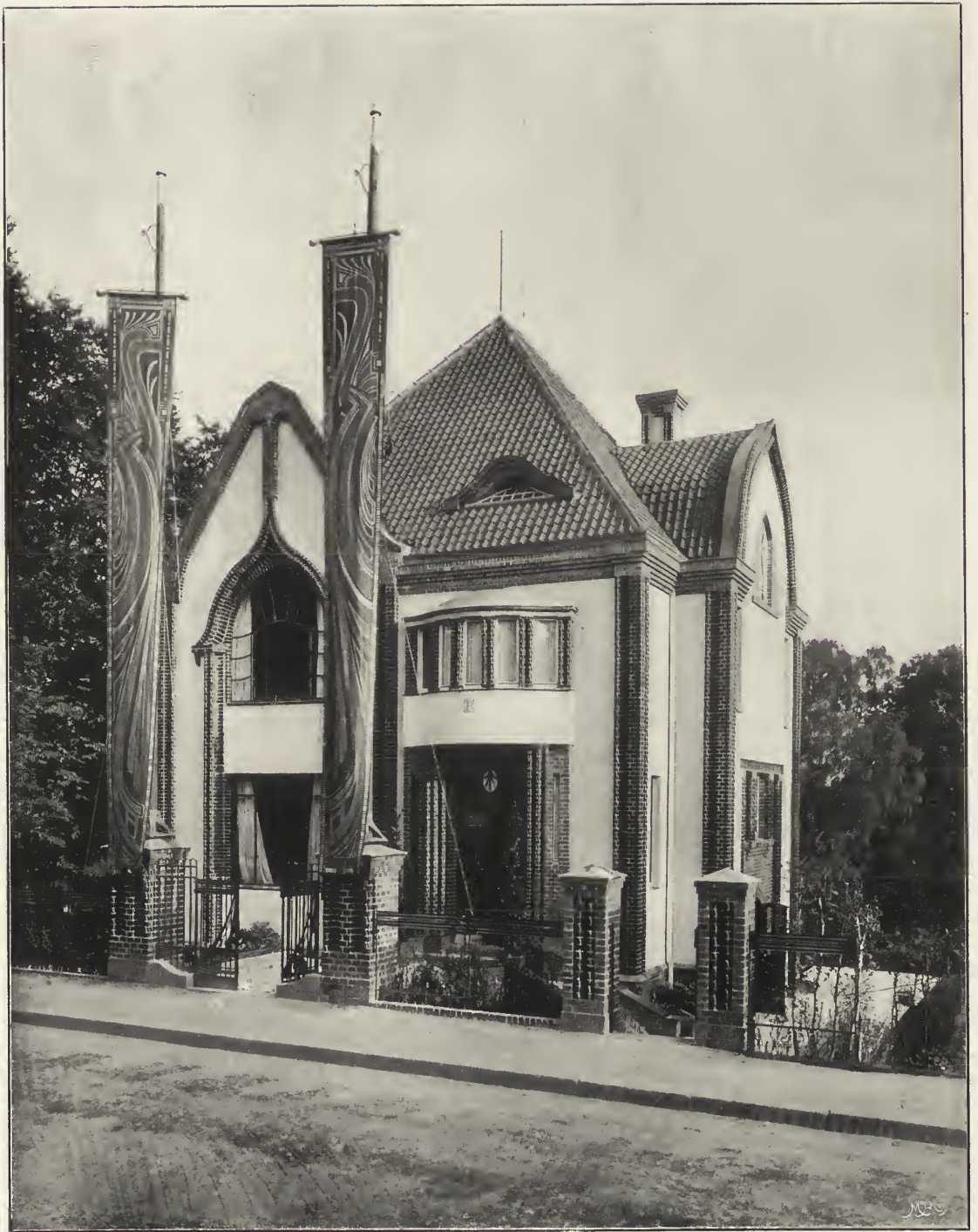
Haus Behrens. • Nord = Ansicht vom Alexandra = Weg. Banner ausgeführt vom St. Bernward = Institut — Mainz.
