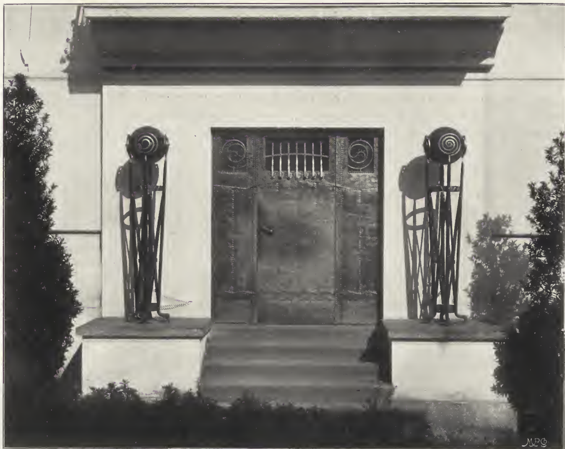
Das Portal des Hauses Habich.
