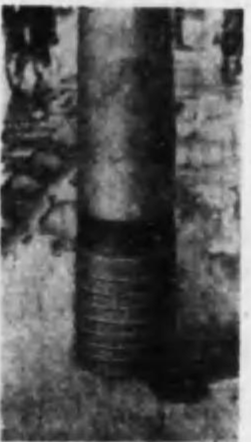
電柱根防腐材施工
