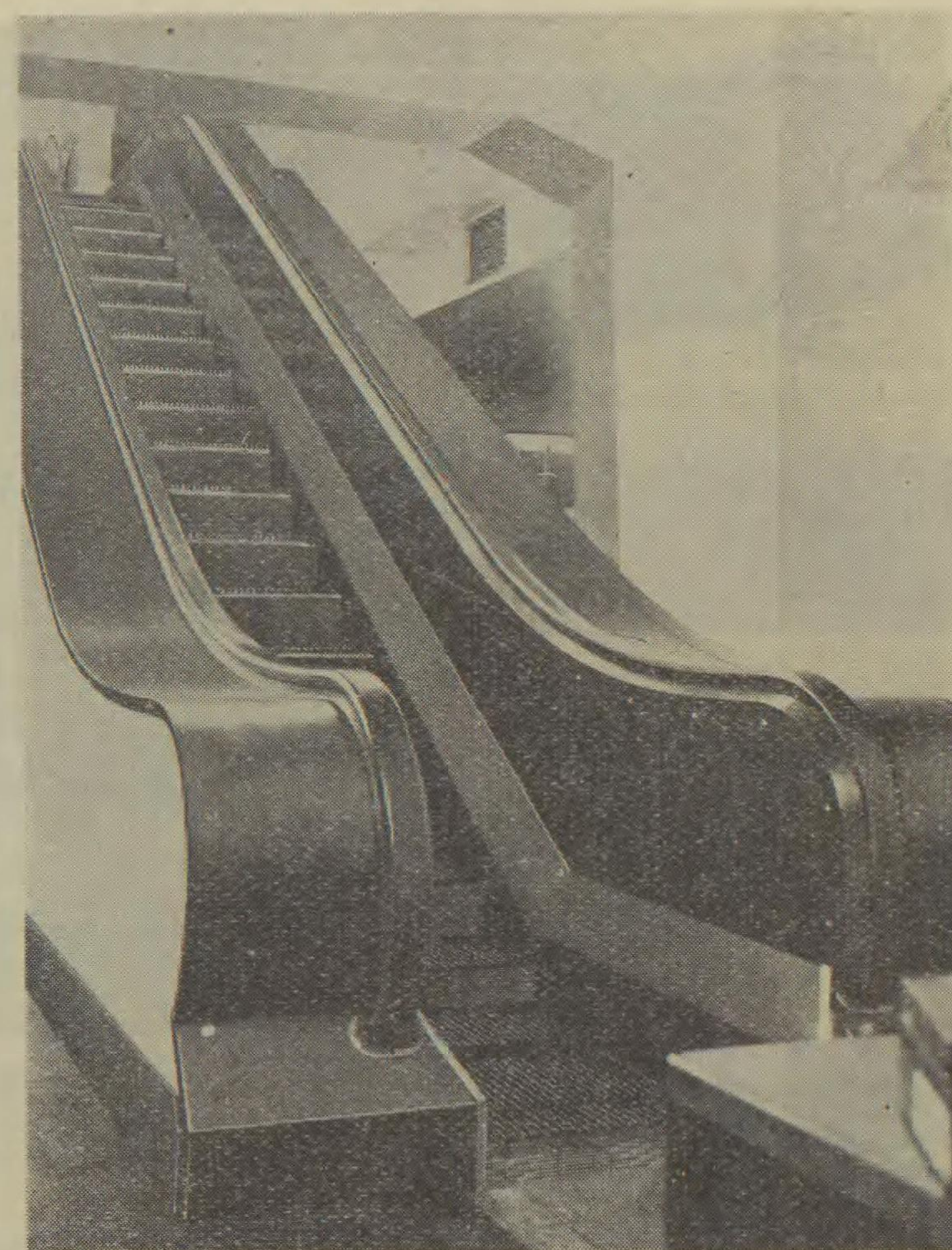
第21圖 自動階段の外装
