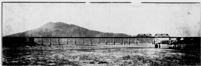
已完之涿河全橋景
