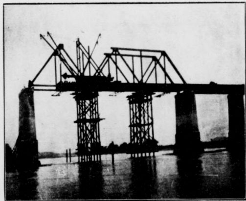
沃河大橋架梁之一
