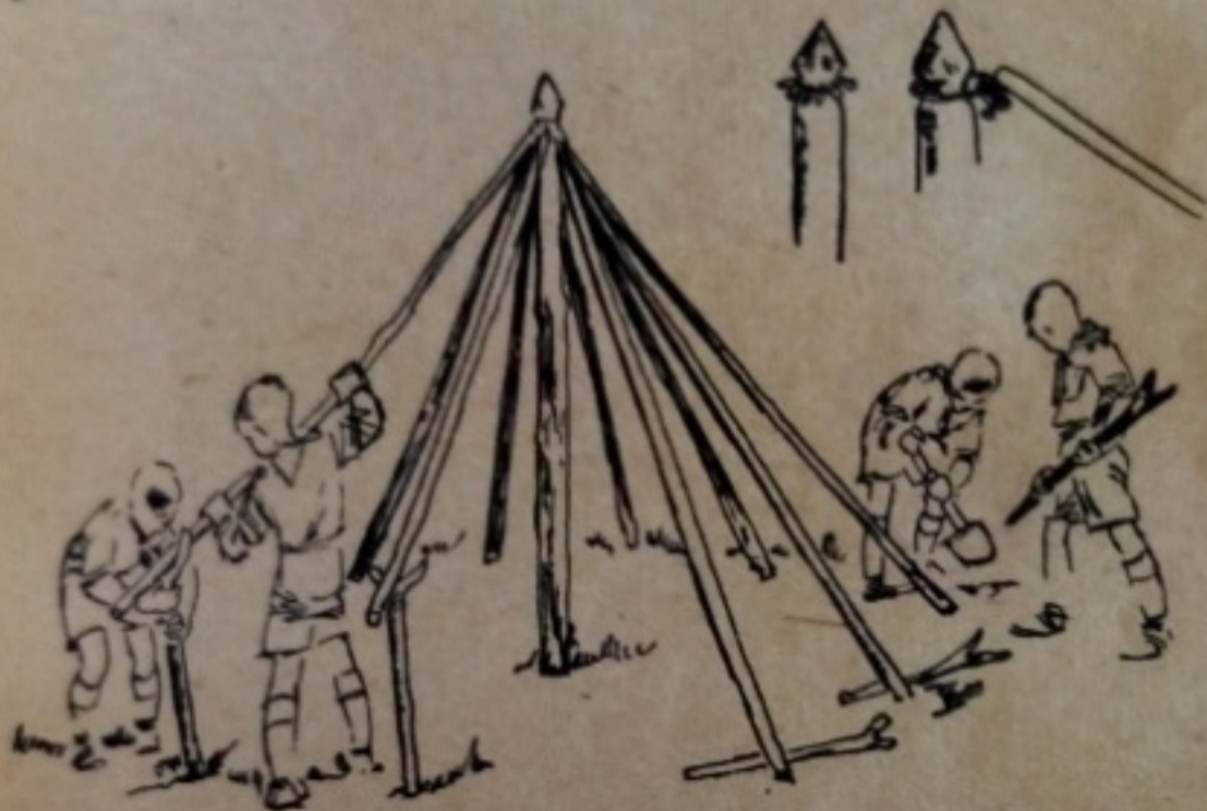
Budowa szkieletu okrągłego szałasu.
