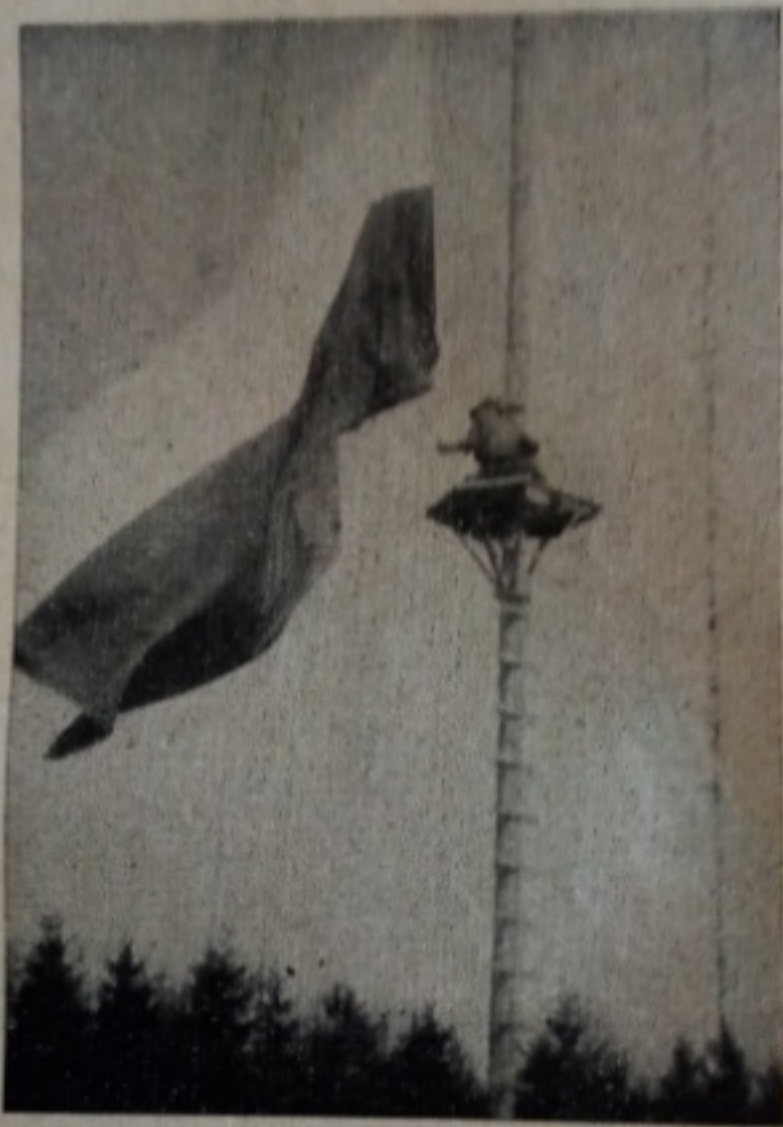
Rys. 16. Wieża na maszcie.
