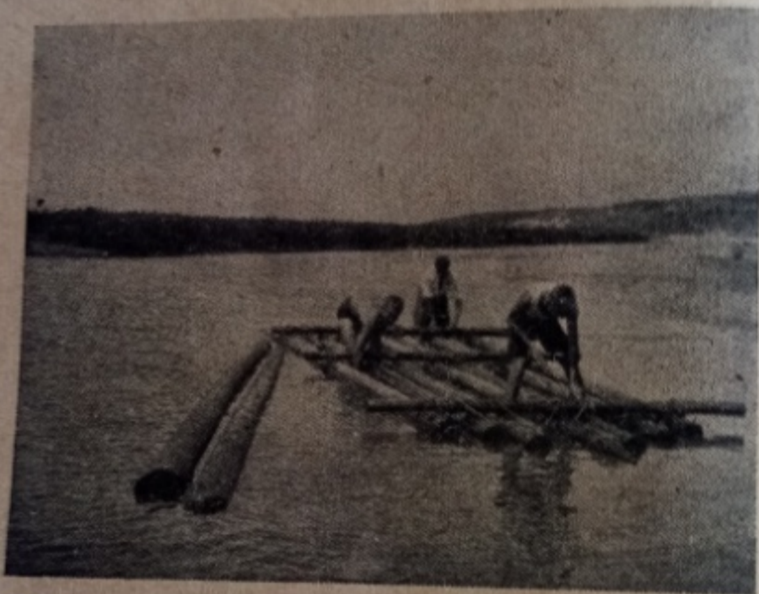
Rys. 4. Budowa tratwy na wodzie.
