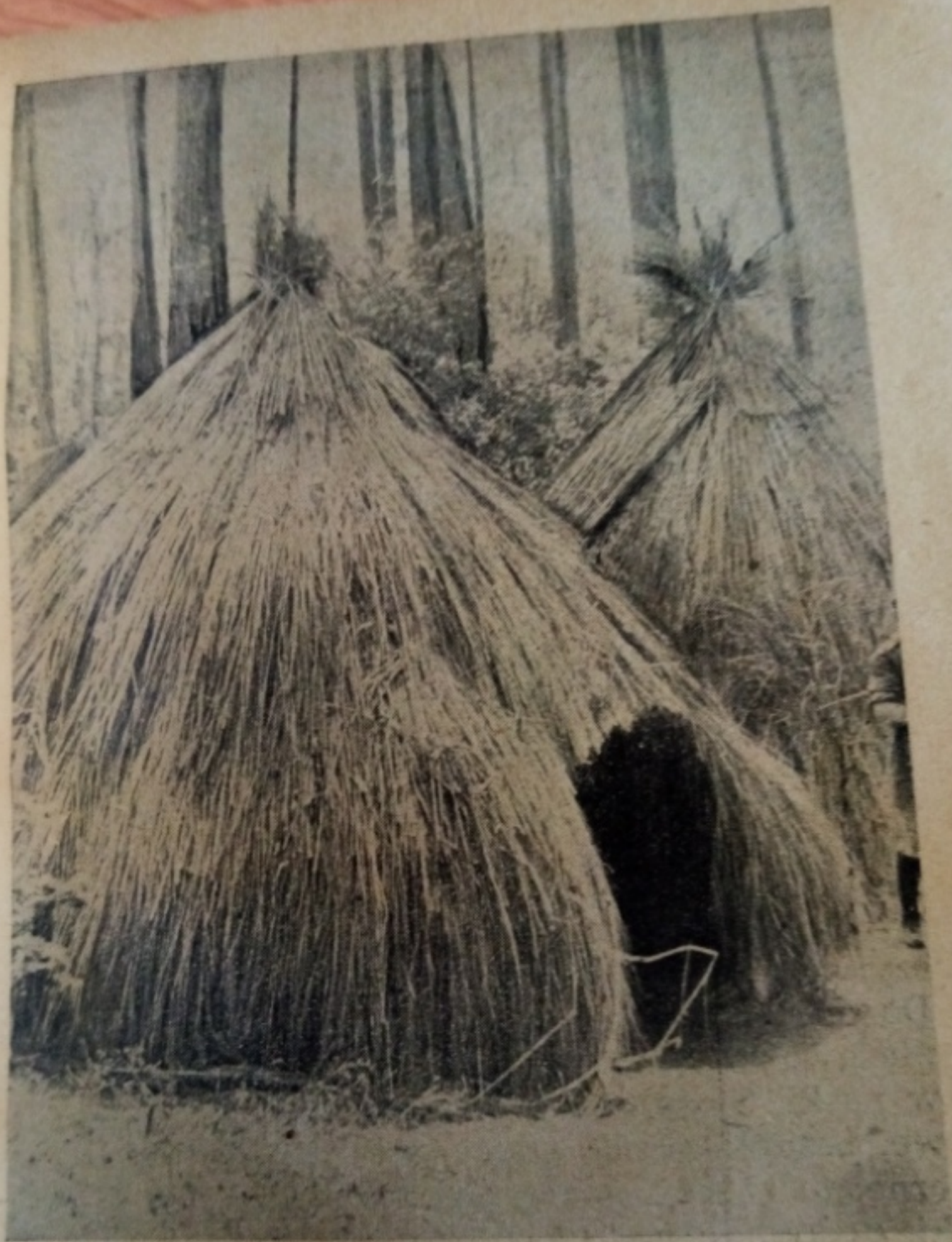
W takim szalasie śpi się jak w kopie siana. Widoczne są dwa rzędy krycia i czapa.
