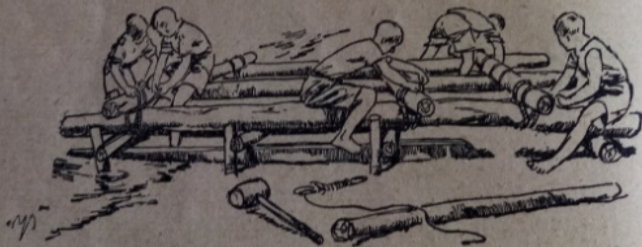
Rys. 6. Budowa tratwy na brzegu.
