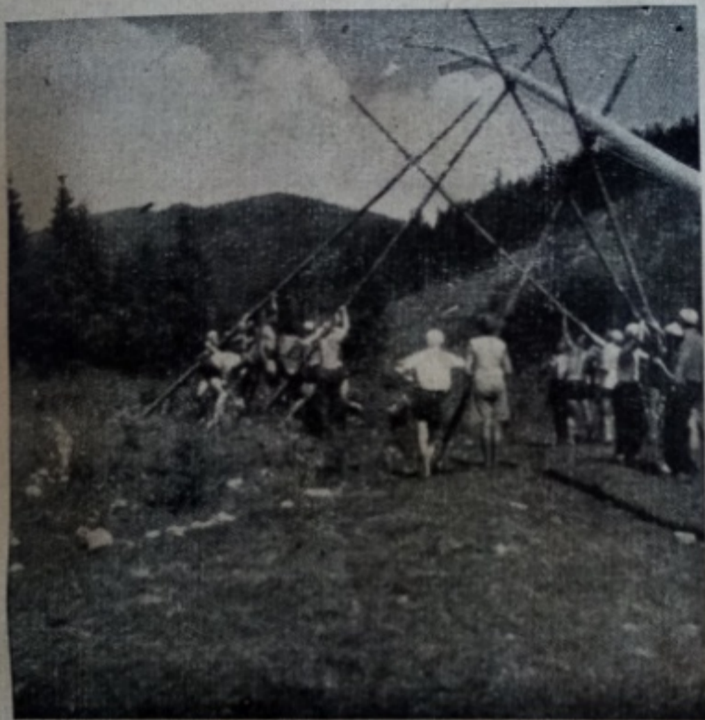
Rys. 4. Podchwytywanie kozłami coraz niżej. Maszt stawia 80 Warsz. Druż. Harc.
