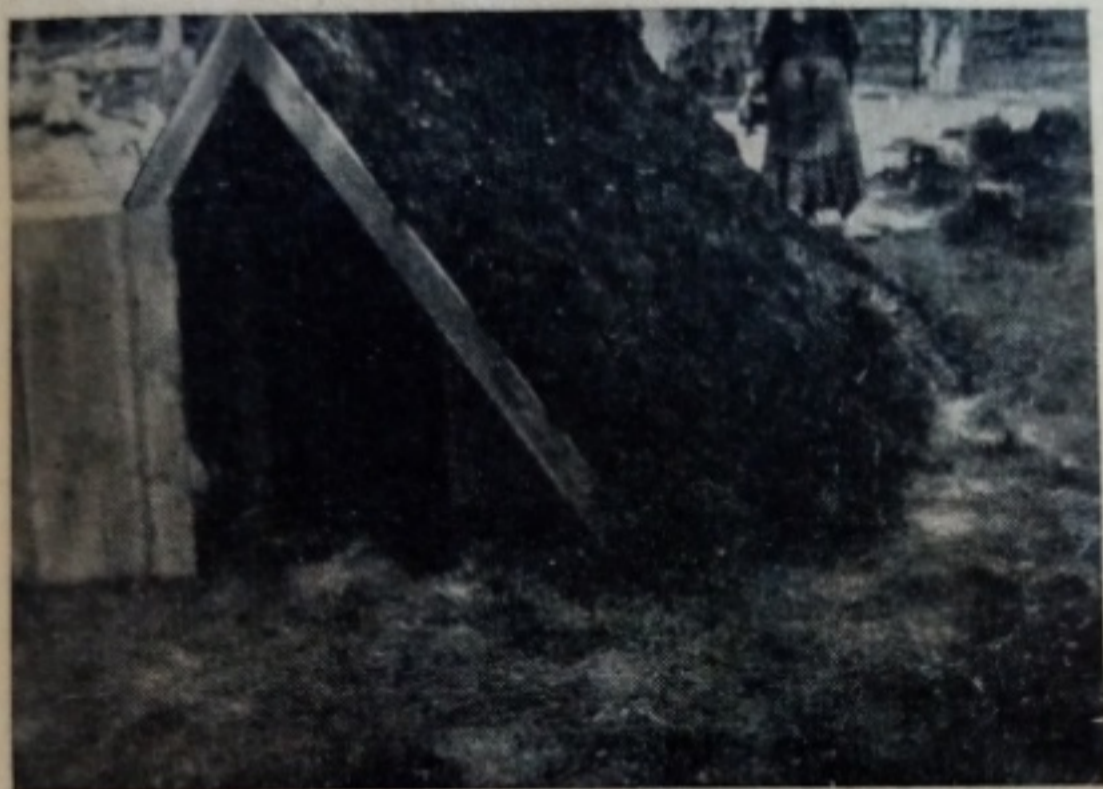
Rys. 16. Piwnica, pokryta ziemią i mchem.
