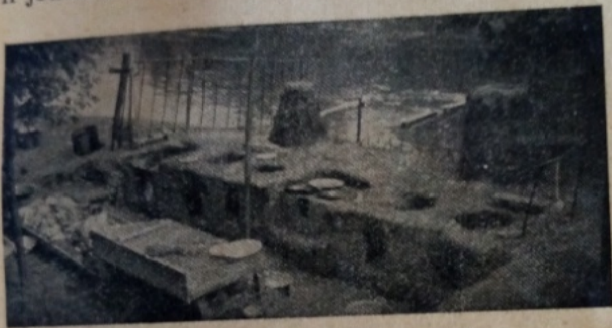
Rys. 5. Jeden komin obsługuje 2—3 paleniska.
