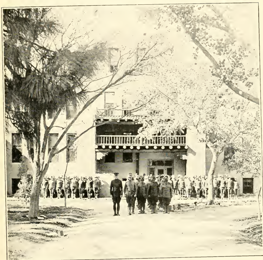
ADMINISTRATION BUILDING (S. A. T. C.)
