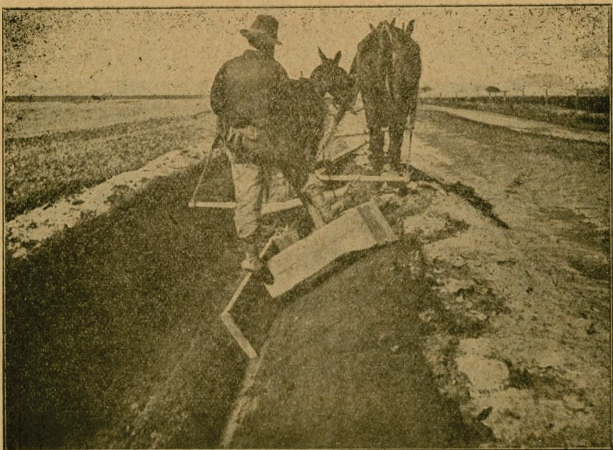
Б. Проведеніе небольшихъ каналовъ при помощи „пчелы“ (bee).
