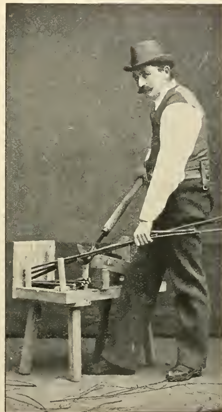
Vorrichtung zum Schneiden von Weidenstecklingen für Massenzucht.
