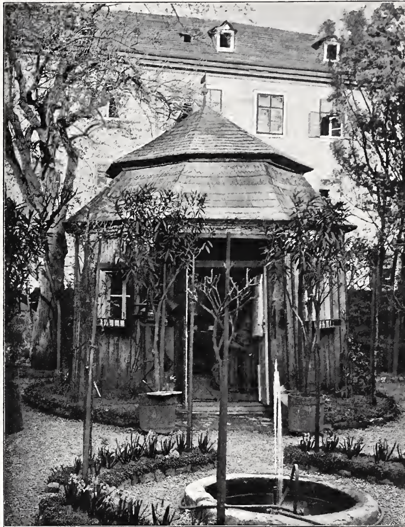
Gartenhäuschen in der Piaristengasse 58
