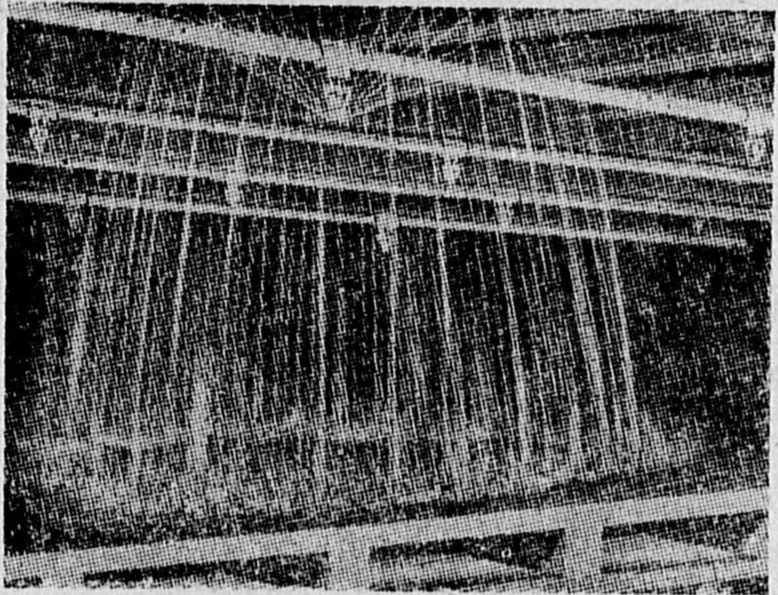
スプリンクラーの噴水せる状態
