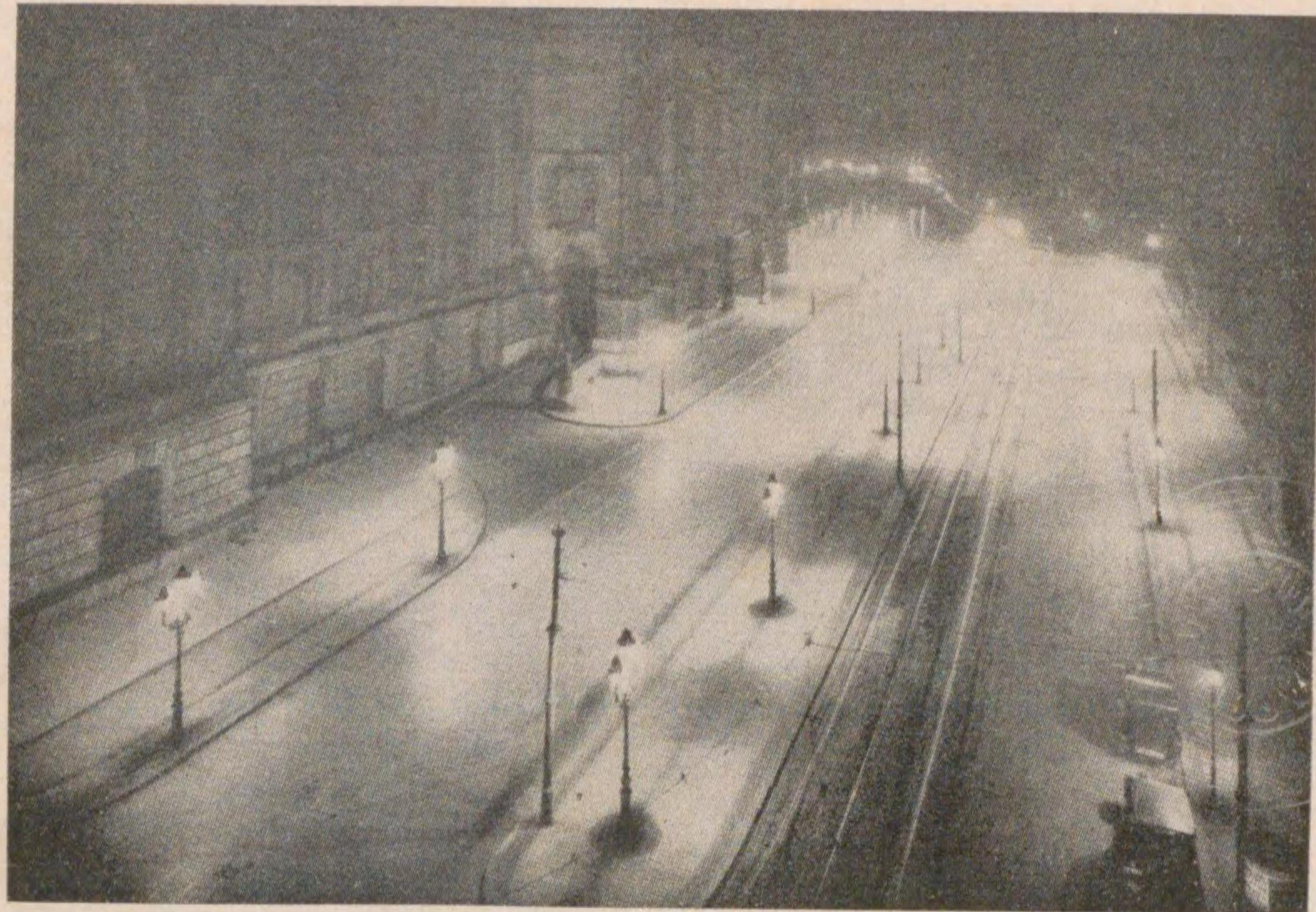
ベルリン、フリードリッヒ・エーベルト街の瓦斯燈 (光源の高さ：左右 4.5米, 中央 4.9米)
