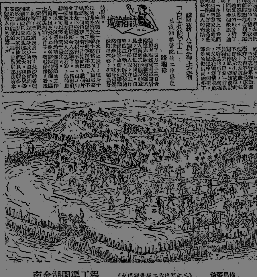
南金湖開渠工程 (大湖開渠工作速寫之三) 黃軍昌作
