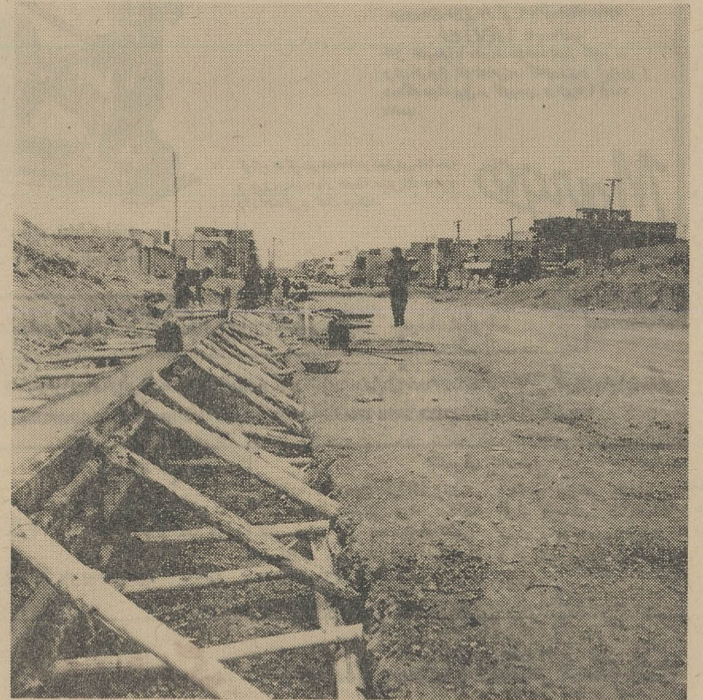
اسفالت خیابان آبادانا شروع شده و مقاطعه کار مشغول نهر سازی است
