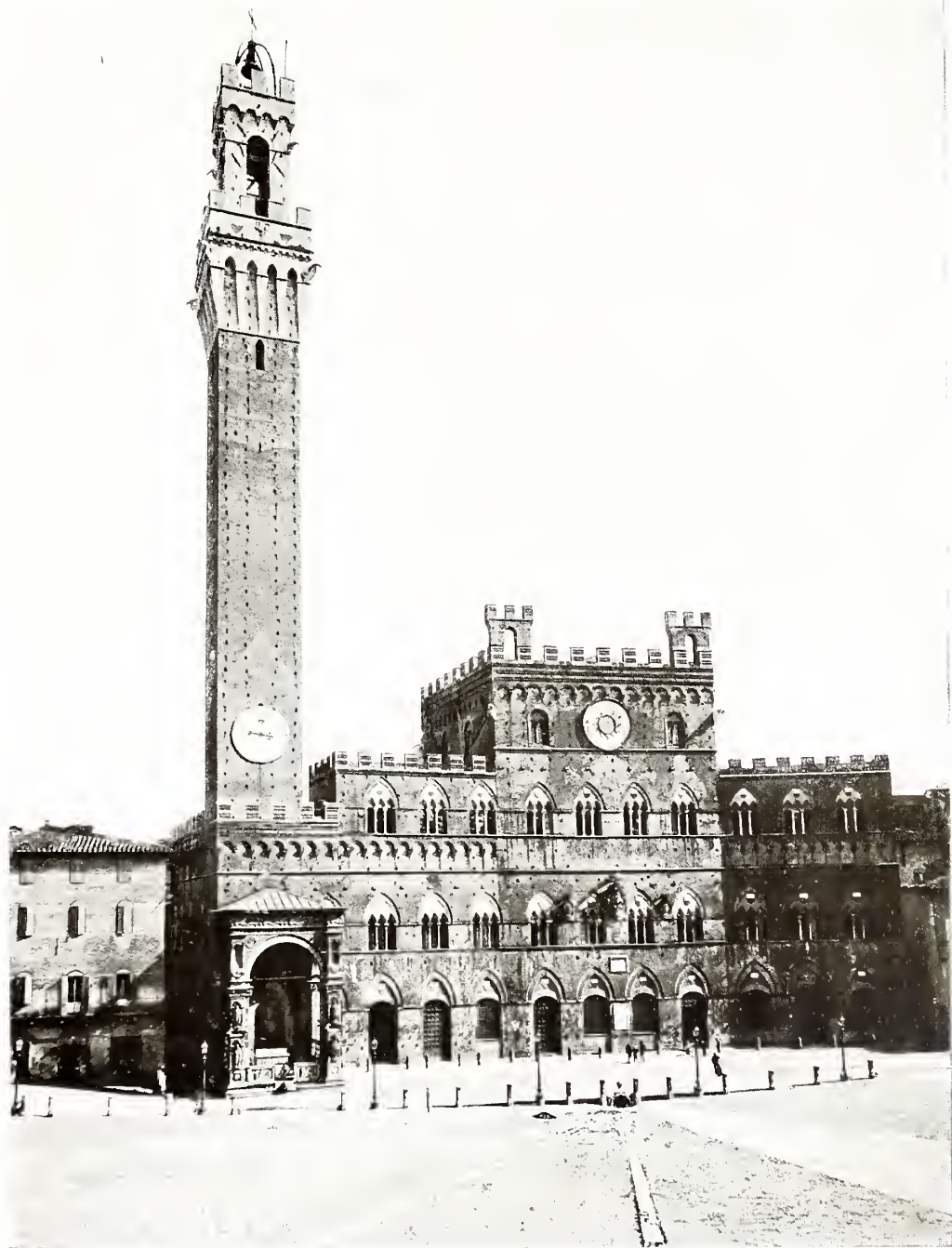
S. PALAZZO PUBBLICO, DOPO I RISTAURI.
