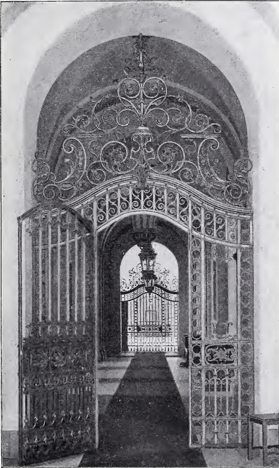
Schmiedeeiserne Thore im Reichsgerichtsgebäude.
