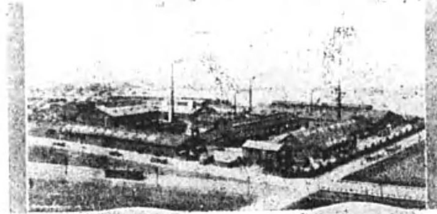
本公司及第一工場
