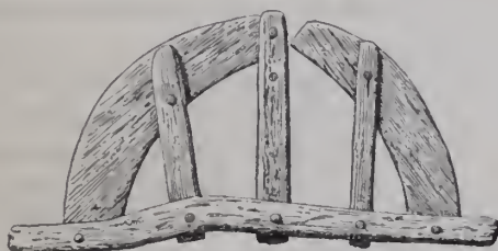
Fig. 8. Hvalfbåge af trä i ena torntrappan.
