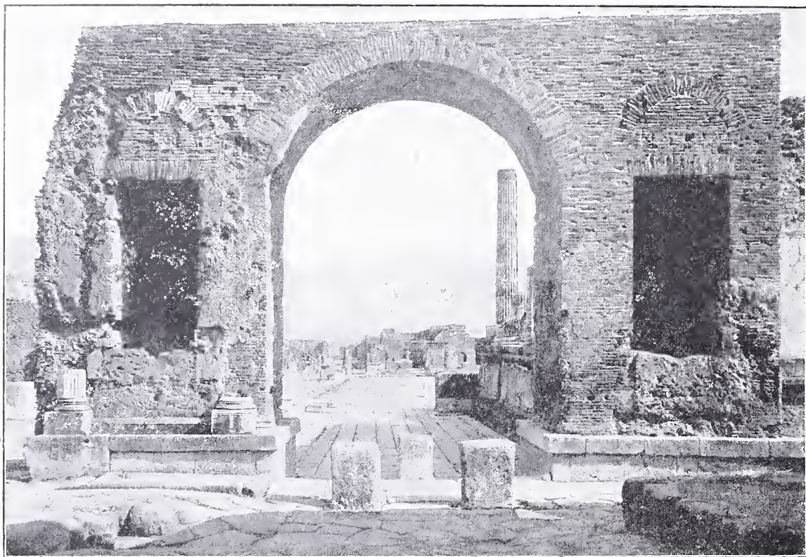
Ruine des Nerobogens. C. (Nordseite.)
