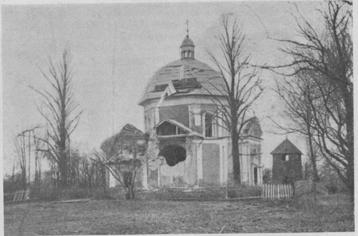
Православная церковь въ Галиціи, разрушенная австрійской артиллеріей. (Съ фот. шт.-кап. Корсакова).
