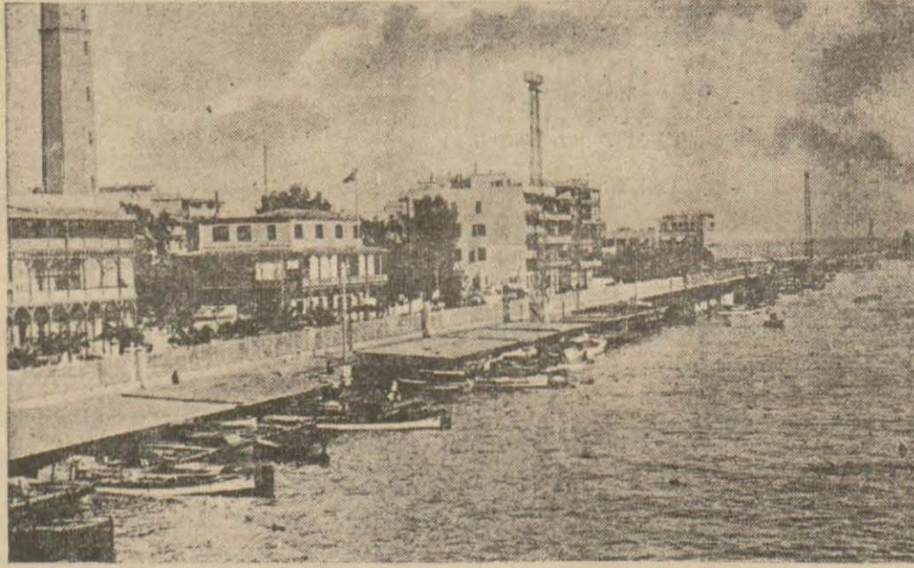
Süveyş kanalı ve Port Salden bir görünüş
