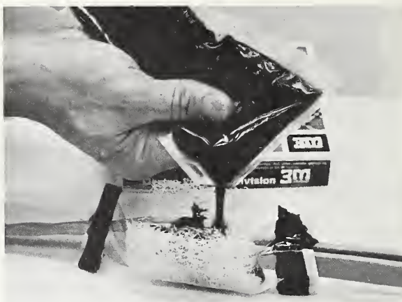
C.— Pour resin into mold.
