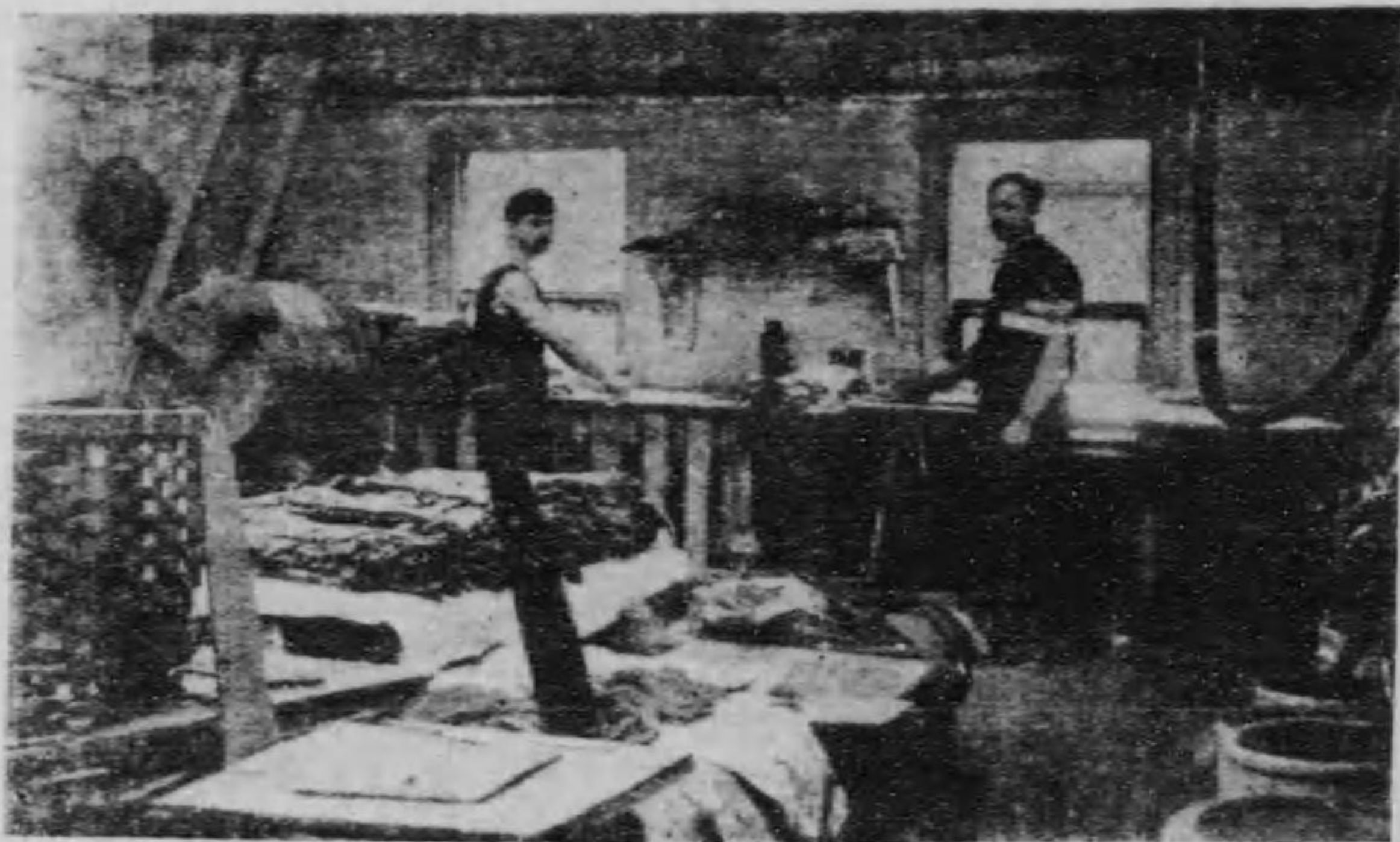
No. 1. アンモニアで漂白せる毛皮。 此作業は咽喉と眼を刺戟す。 此室には煙を除去する導管の設備がない。
