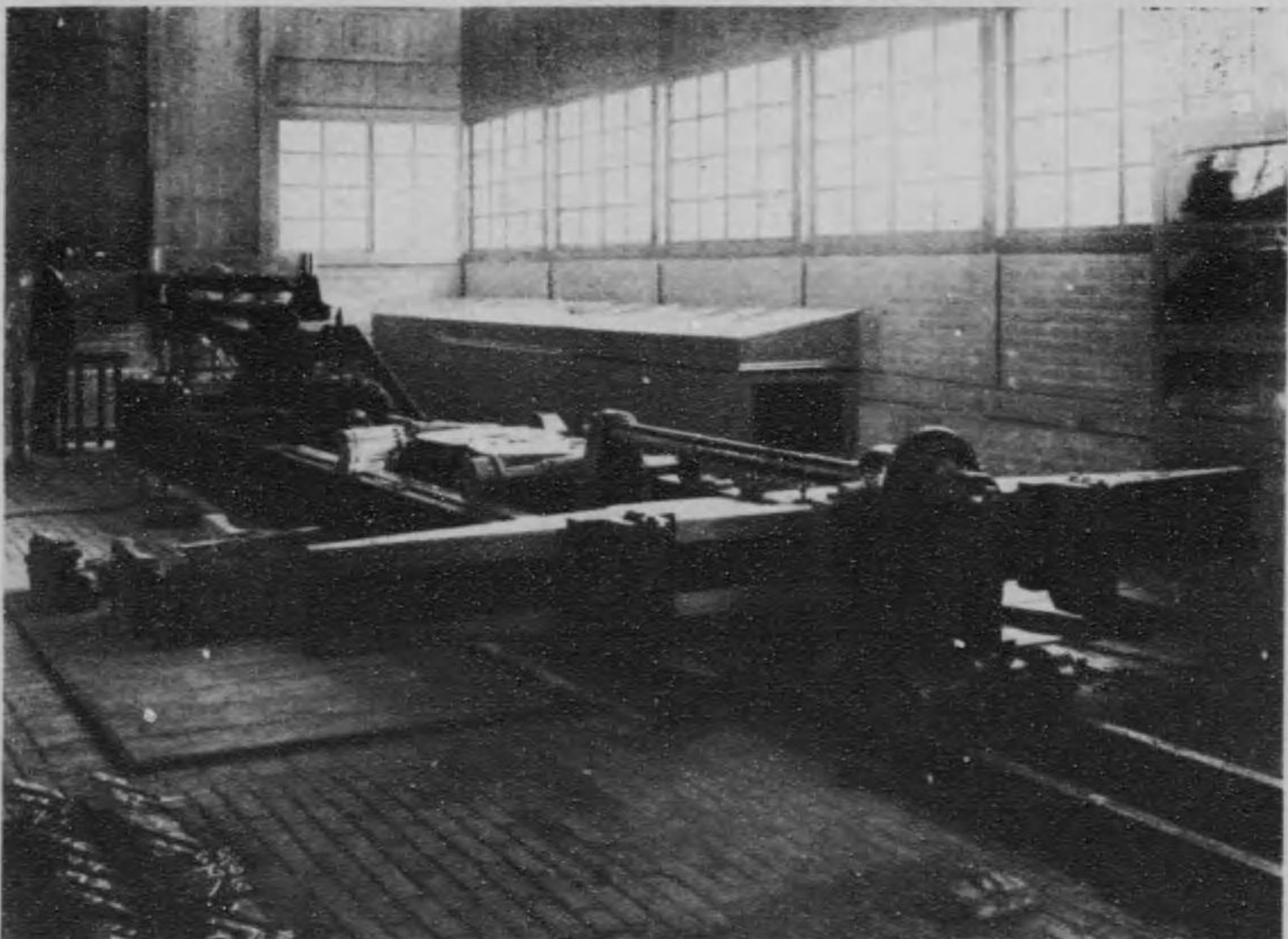
製品試驗所 MECHANICAL TESTING LABORATORY. 五百噸強弱試驗機 150 TON TESTING MACHINE.
