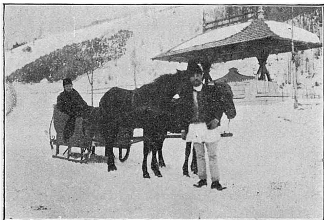
În inspecția căii naționale Cămpina-Predeal, în toilul erii.
