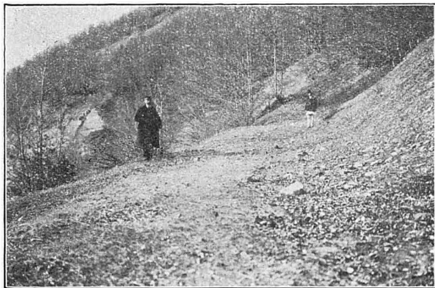
Vedere asupra unui crâmpci din vechiul drum al Brașovului, deasupra actualei căi Câmpina-Predeal, îndată după podul Orășilor. Se distinge bine încă platforma vechiului drum. (Vezi pag. 52—59).
