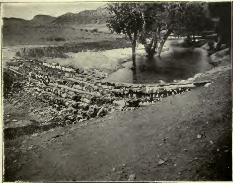
FIG. B.—Log and earth dam. Cimarron River, N. Mex.
