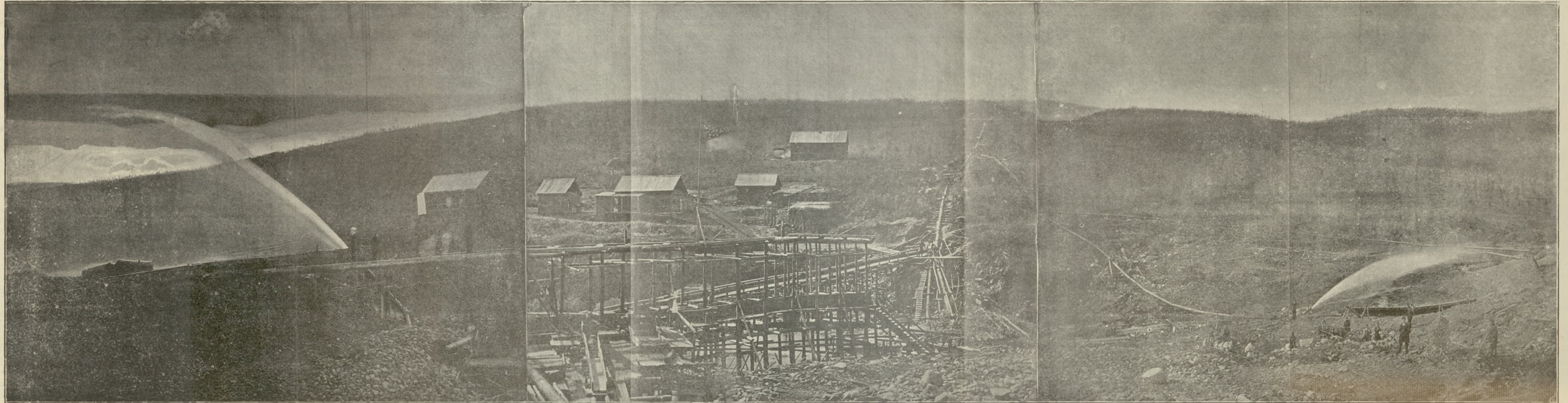
Галечный элеваторъ, выбрасывающій свободною струею. Трубы для отвода Гальки въ отваль.
