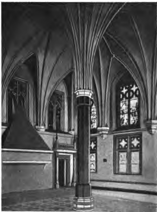
Одноколонный залъ въ Маріенбургскомъ замкѣ.
