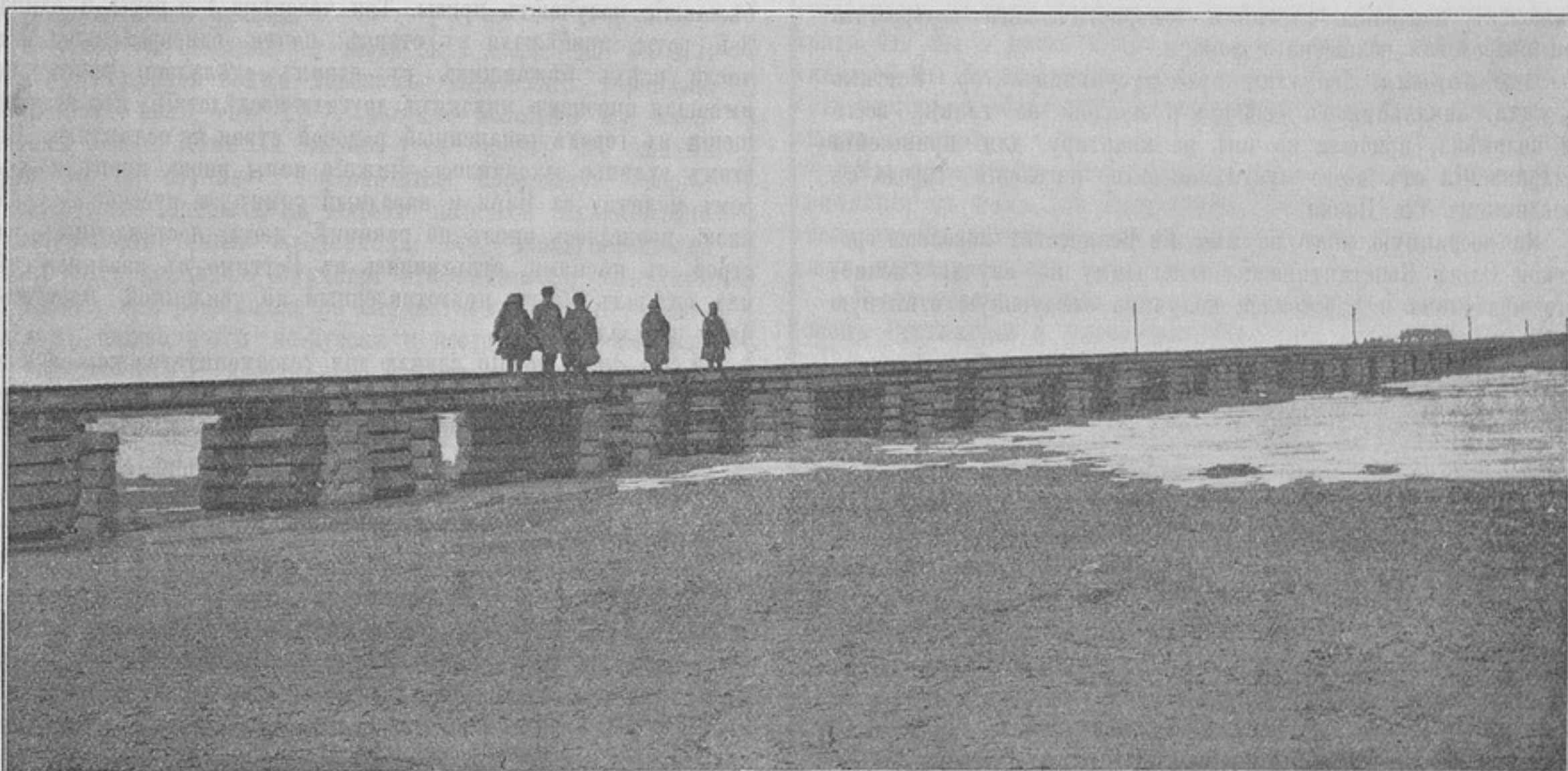
Уцѣлѣвшій послѣ половодья, желѣзнодорожный мостъ чрезъ рѣку Хун-хэ, длиною 210 саж., построенный капитаномъ Массальскимъ (видъ съ лѣваго берега) (къ статьѣ «Мостъ черезъ рѣку Хун-хэ»).
