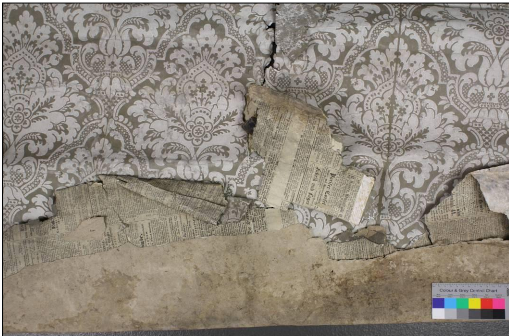
Abb. 37: Umgeklapptes unteres Teil der Tapetenbahn mit hadernhaltiger Makulatur und Zeitungspapier. Das Zeitungspapier ist stark eingerissen und wird nur noch durch kleine Stücke festgehalten.
