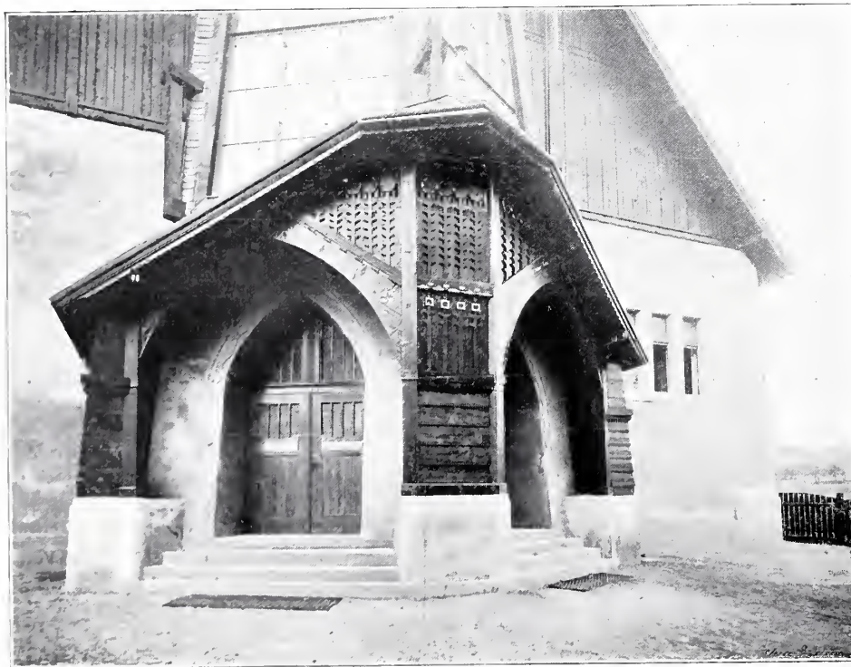
Prozatímní katolický kostel v Praze-VIII. — Hlavní vchod. Architekt M. Biecha.
