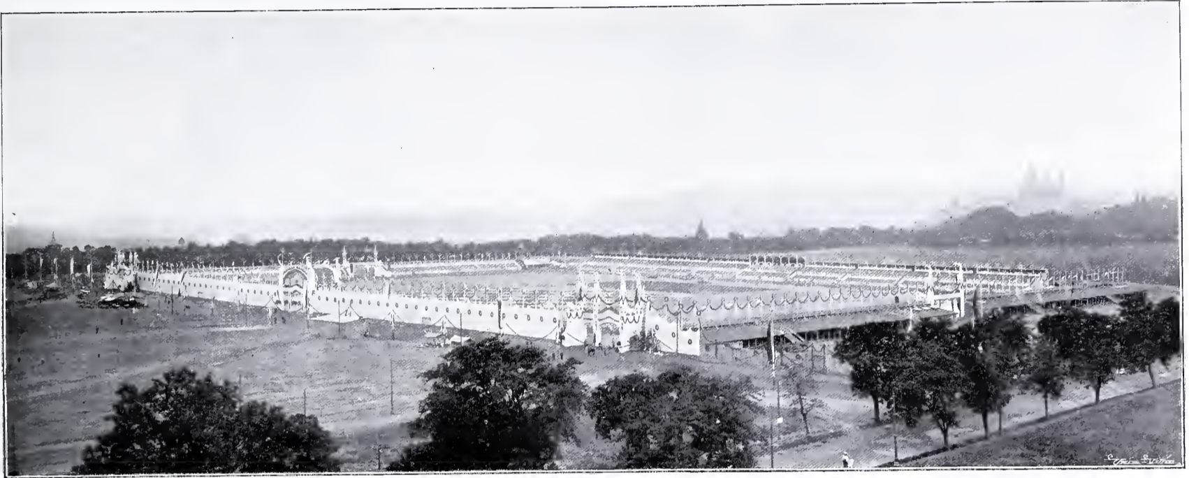
Architektonická úprava cvičiště V. sletu všesokolského v Praze. Stav. r. L. Čížek. — Celkový pohled.
