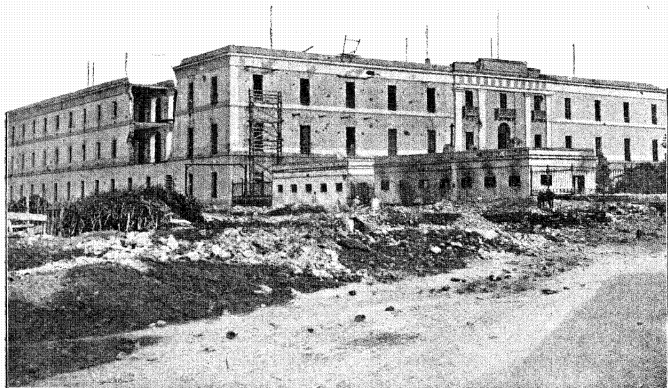
Estado ruinoso en que quedó el cuartel de Ballajá después del bombardeo.
