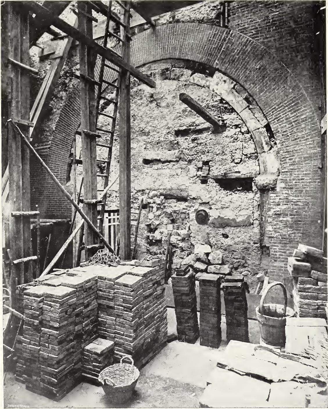
Fig. 51 — Chiusura della controarcata.
