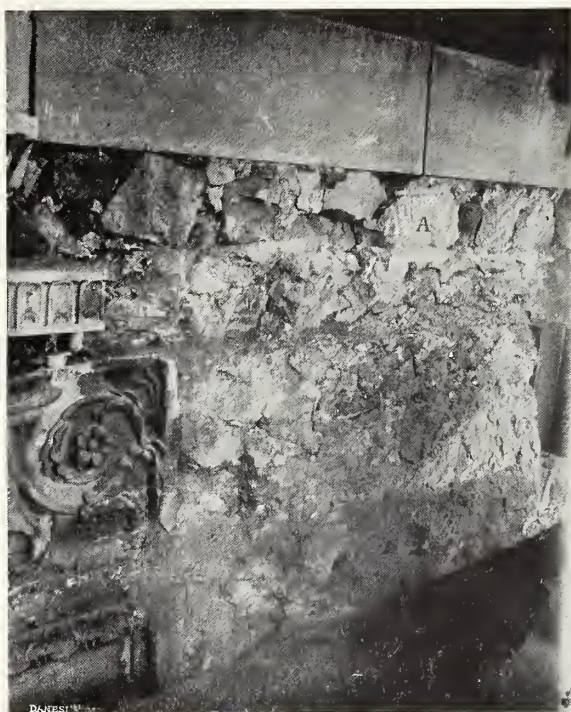
Fig. 79 — Cornice di coronamento al binato destro del 2° ordine durante i lavori (V. pag. 149).
