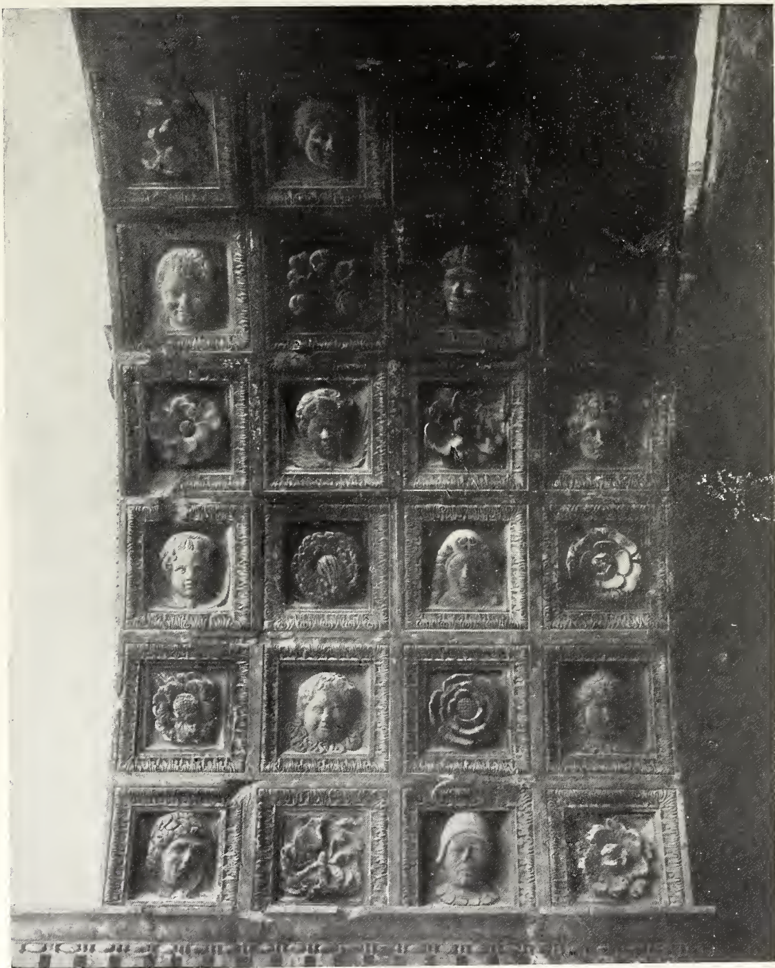
Fig. 54 — Intradosso della 2ª arcata (lato sinistro), liberato dalla muratura.
