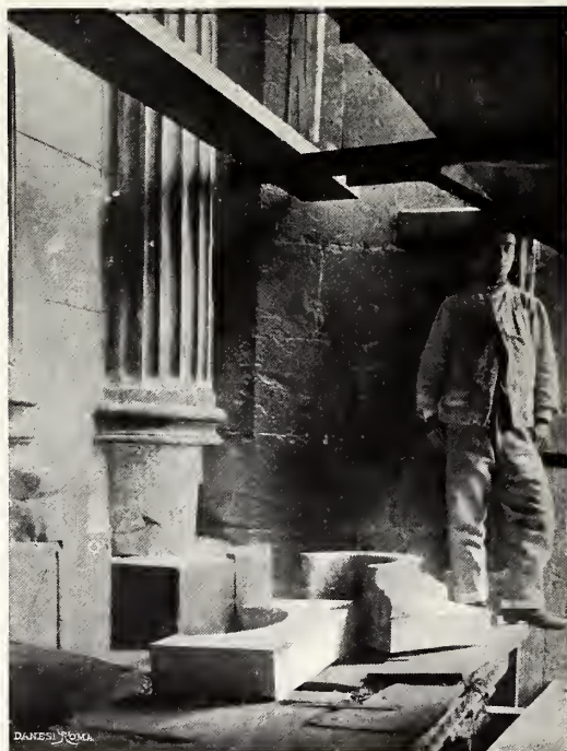
Fig. 78 — Rivestimenti marmorei per la base della colonna destra (Binato destro del 2° ordine).
