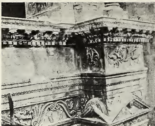
Fig. 77 — Cornice sull'edicola destra dopo la sua ricomposizione.
