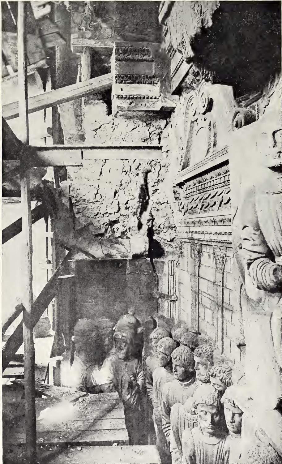
Fig. 31 — Particolare della fig. 29, dopo la rimozione dei blocchi.
