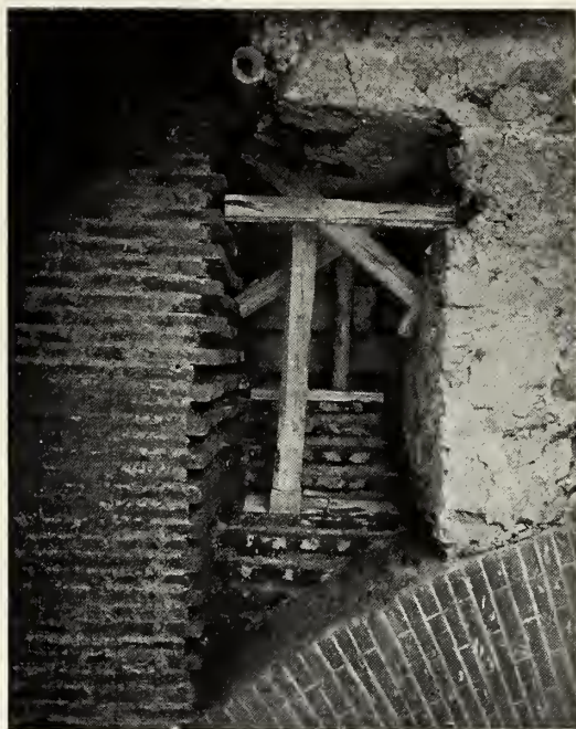
Fig. 50 — Saggio di lavoro a scuci e cuci .
