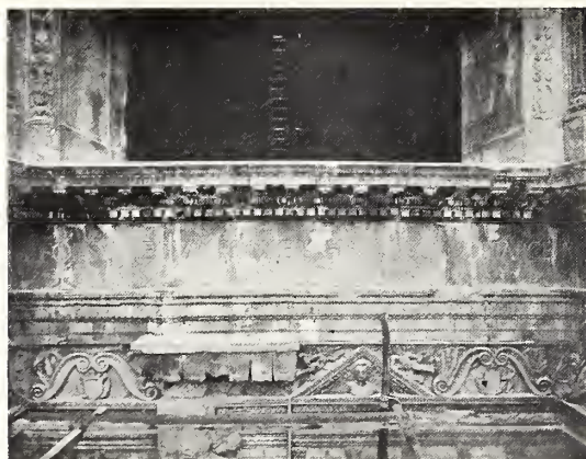
Fig. 88 — (Segue a fig. da 85 a 87) Dopo il ripristino.
