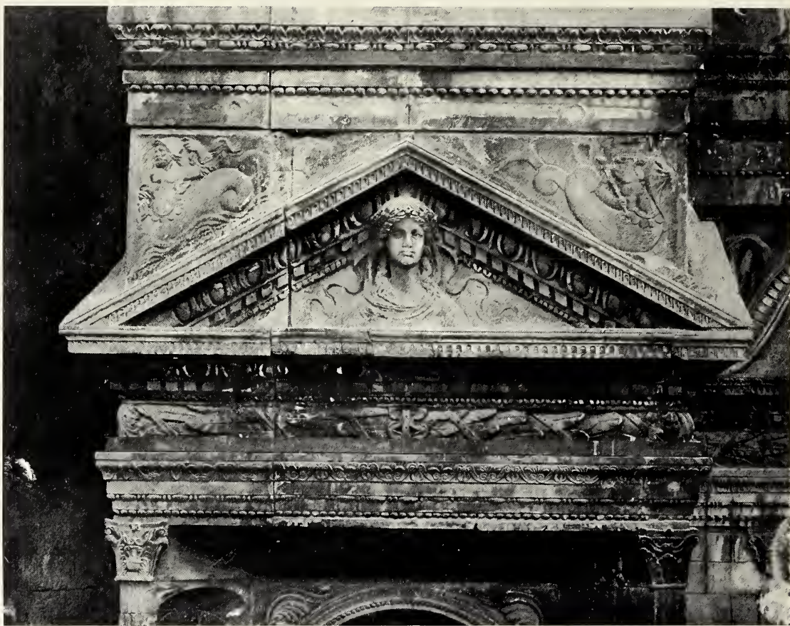
Fig. 36 — Timpano dell'edicola sinistra, dopo il restauro.
