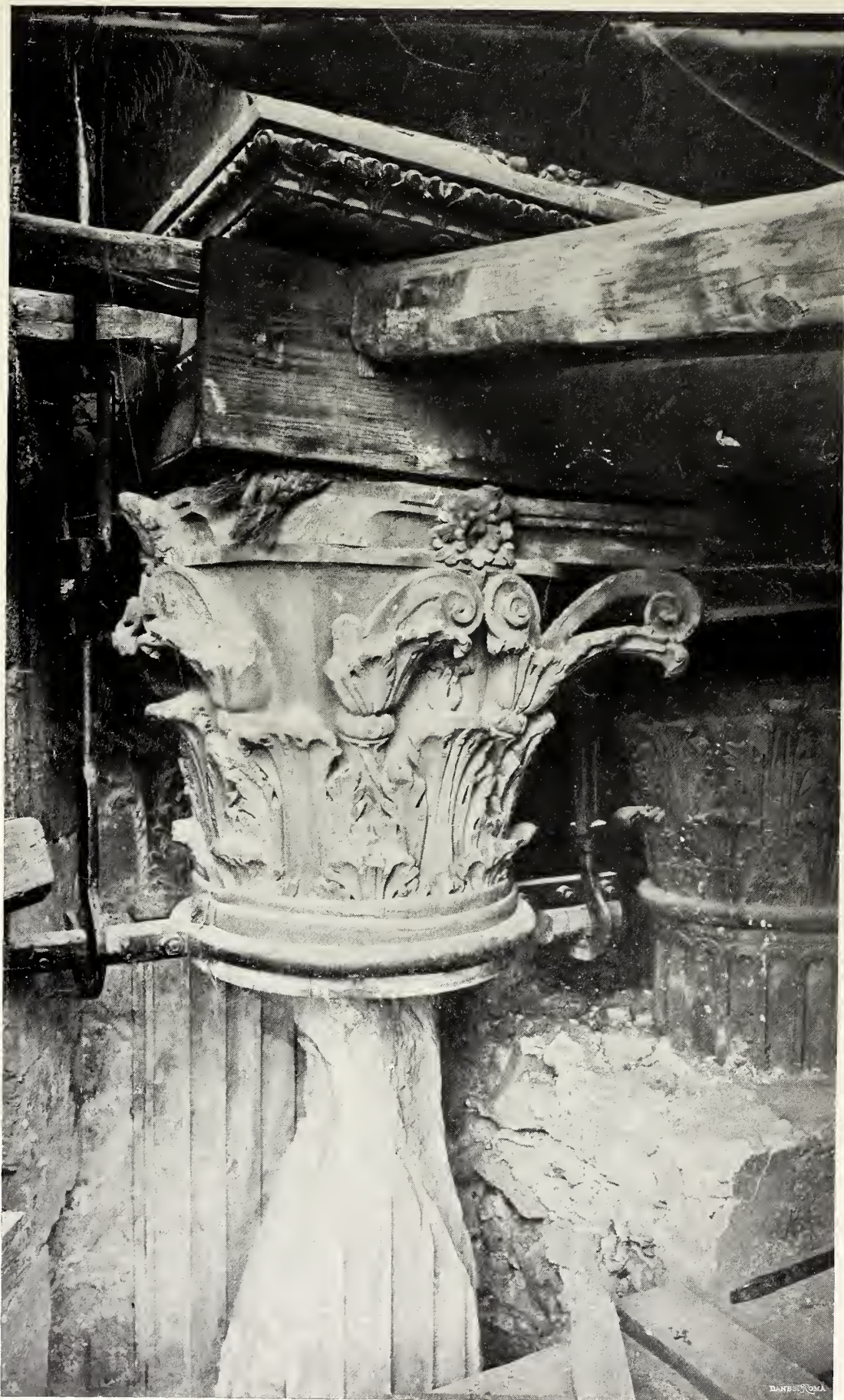
Fig. 41 — Capite'lo sinistro del binato sinistro (1° ordine), con l'imbracatura metallica.
