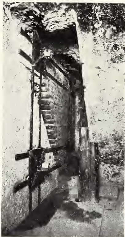
Fig. 33 — Telaio metallico applicato alle spalle dell'edicola sinistra (V. fig. 32 e pag. 130).
