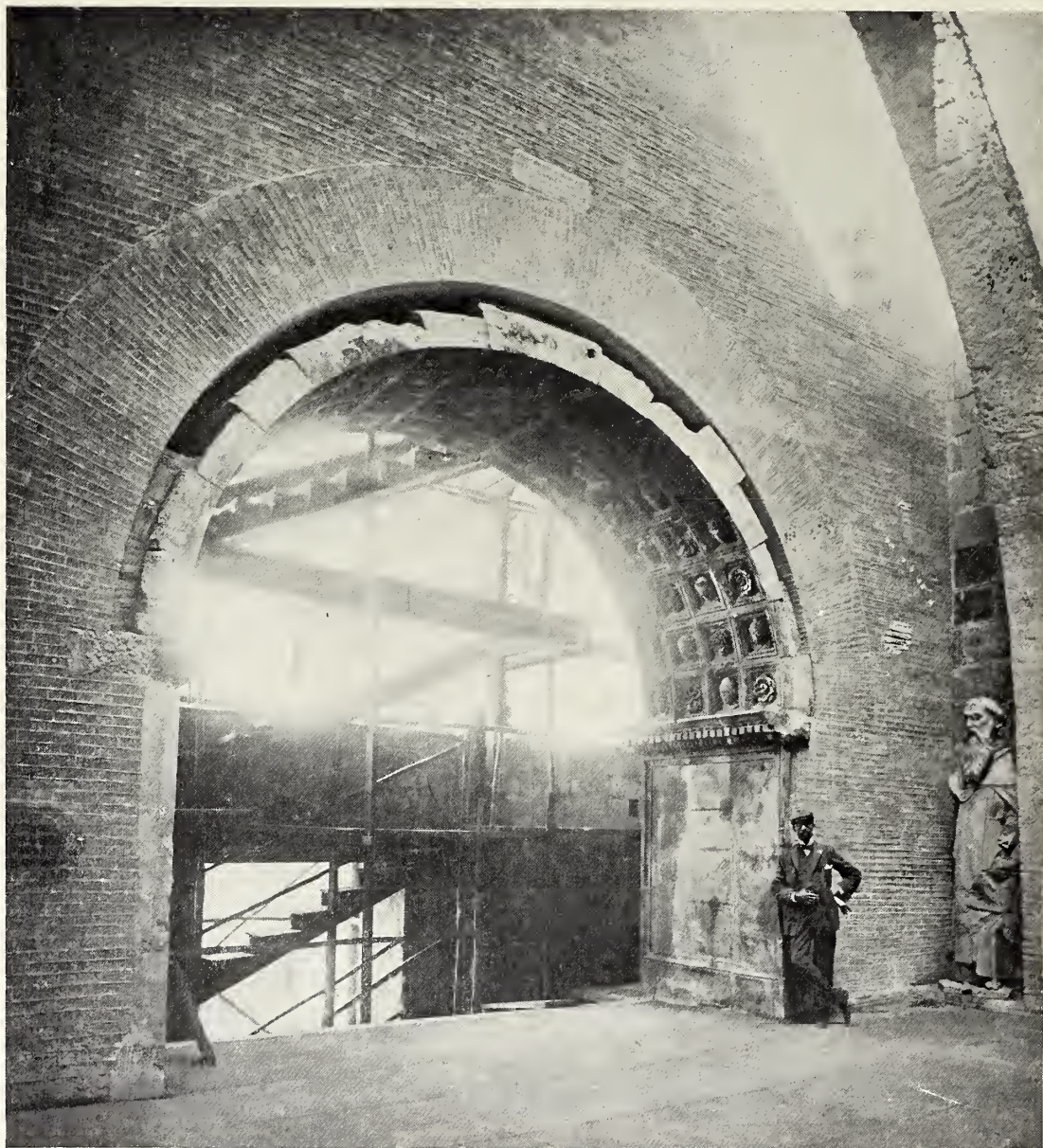
Fig. 52 — Intradosso dell'arco del 2° ordine, dopo la demolizione del muro di sostegno.
