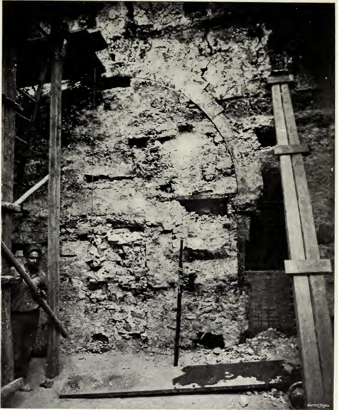
Fig. 48 — Controarcata. Inizio del lavoro di scuci e cuci .
