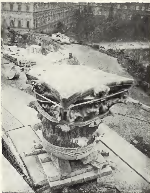
Fig. 70 — Un capitello sul carrello di scivolamento.
