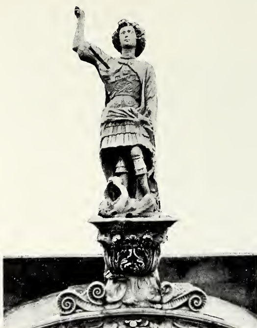
Fig. 127 — Statua di San Michele, dopo la demolizione dell'attico.
