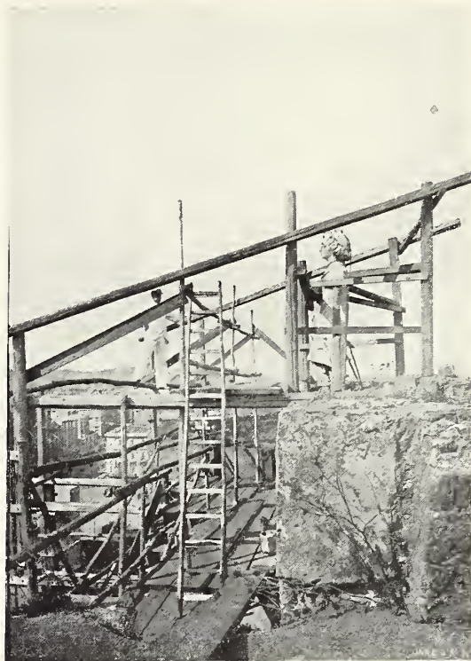
Fig. 67 — Attico sul timpano curvilineo prima della demolizione.
