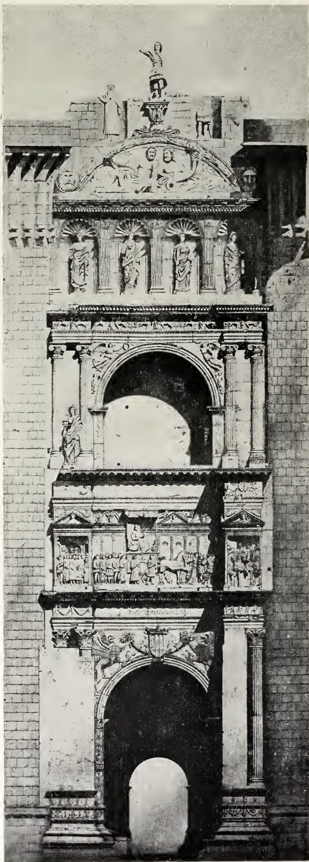
Fig. 27 — L'arco dopo la ricostruzione del torrione (ril. e dis. di A. Avena). (1)
