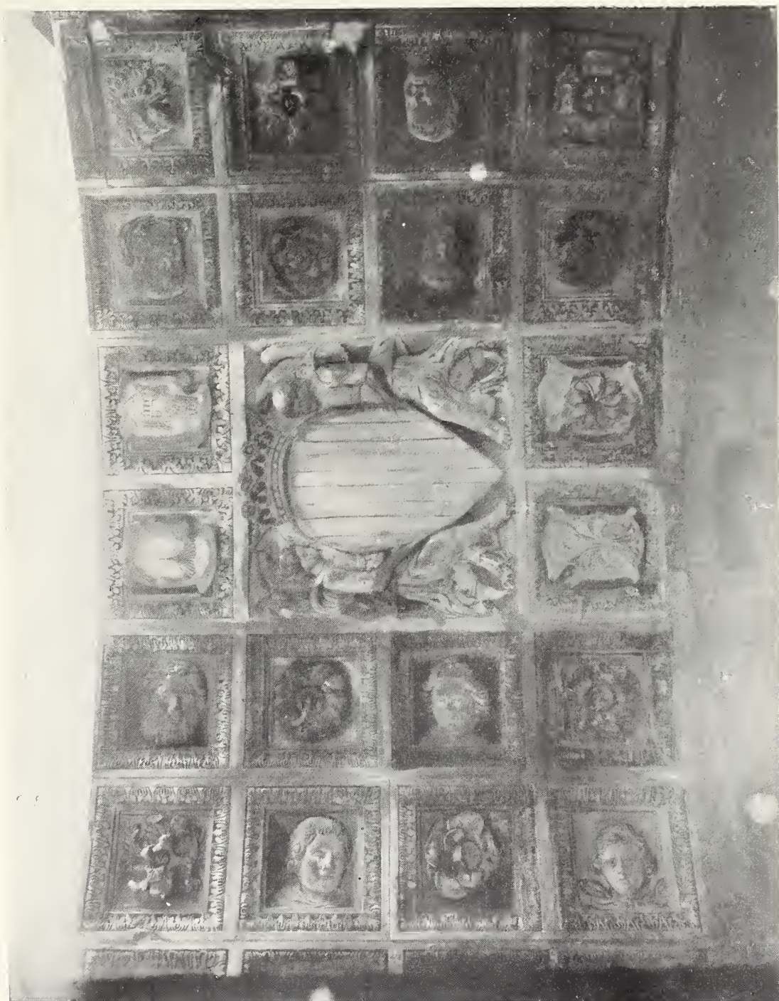
Fig. 55 — Intradosso della 2ª arcata (parte centrale), liberato dalla muratura.
