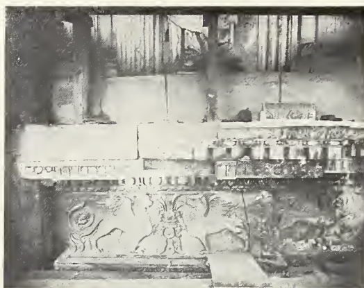
Fig. 83 — Coronamento del binato sinistro (2° ordine), prima del restauro.
