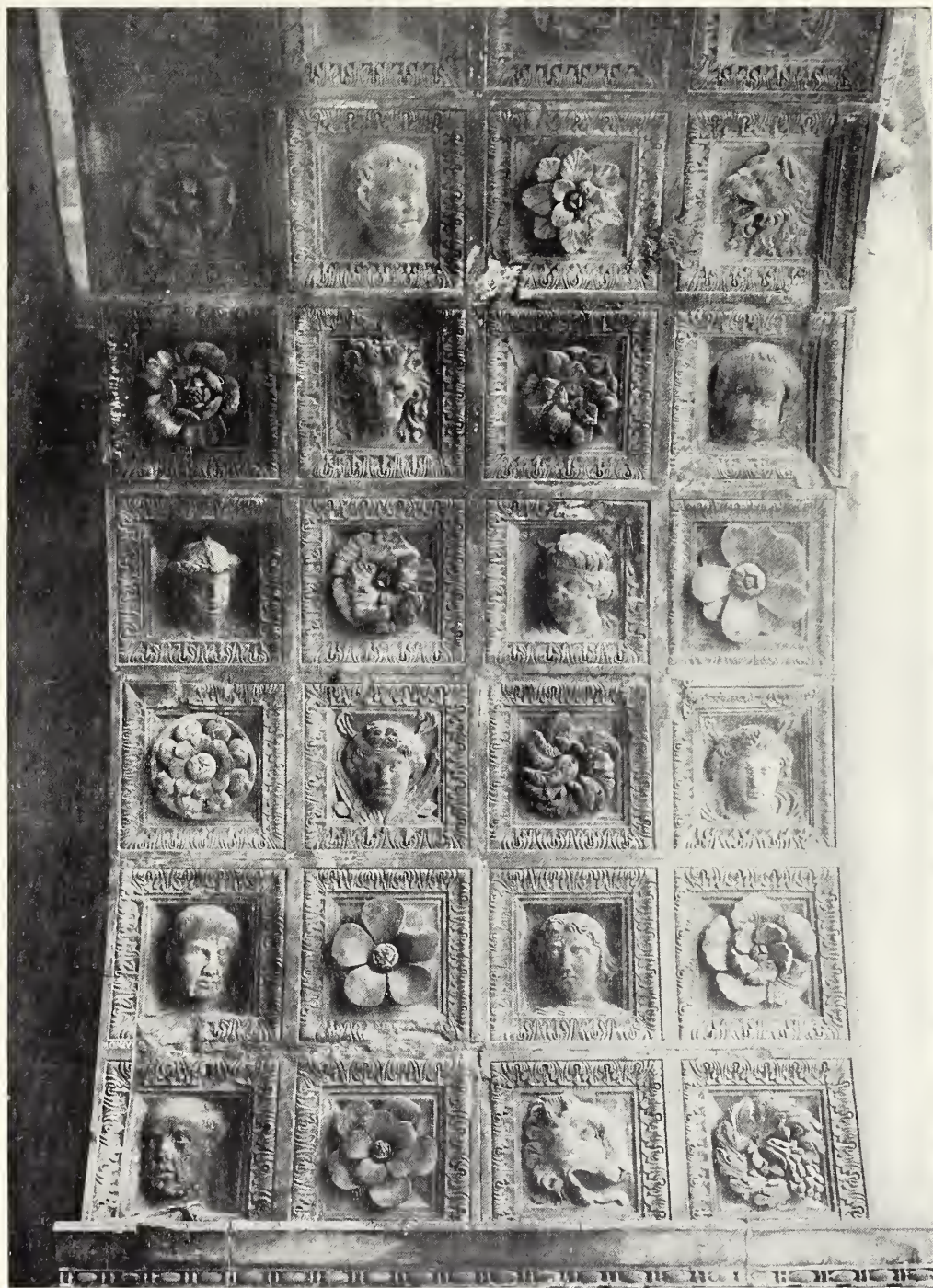
Fig. 56 — Intradosso della 2ª arcata (lato destro), liberato dalla muratura.
