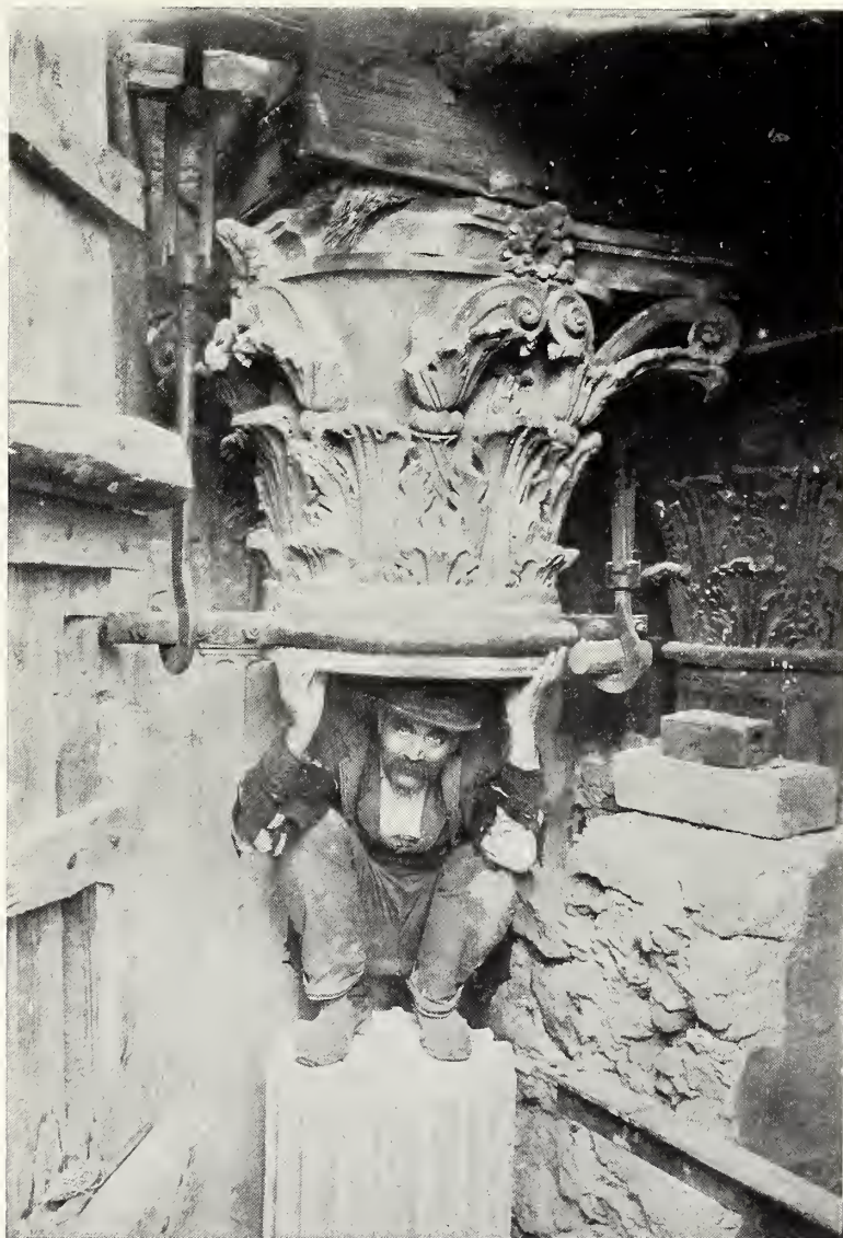
Fig. 42 — Colonna sinistra del binato sinistro (1° ordine), dopo il taglio della parte scheggiata
