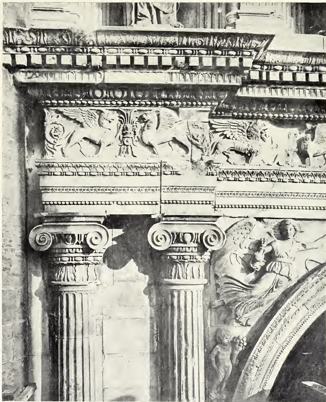
Fig. 115 — Binato sinistro (2° ordine), dopo il restauro.
