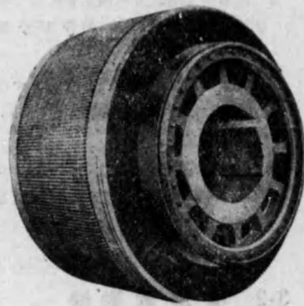
電機子 (4500馬力電動機用)
