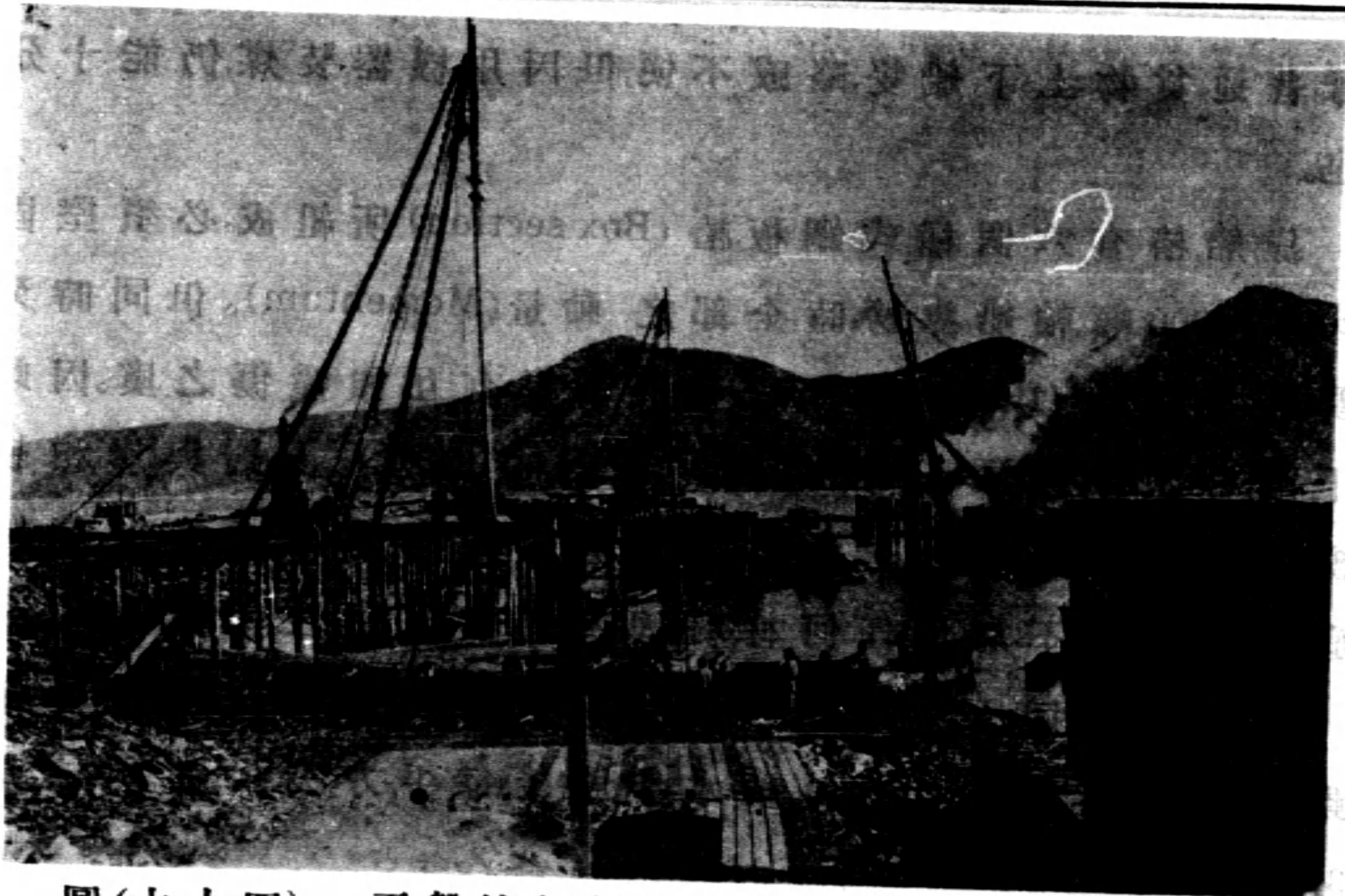
圖(六十四) 兩盤樁架打樁工作及承台木板完成一部 於三月中先後完成。內堤石牆及中部填土同時進行，二號碼頭於 五月初全部完竣(圖六十五)，大功告成。數年來'歷盡艱'苦，慘淡經 營，至此得告一段落。
