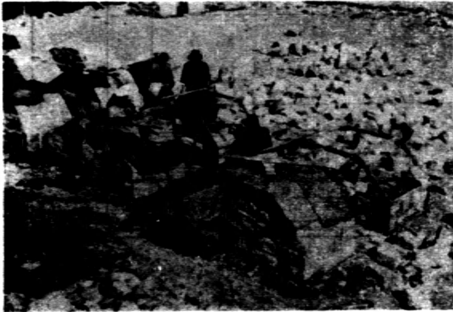
圖(四十五)工作中壓鎮坡脚之洋灰砌成石塊(重五噸)
