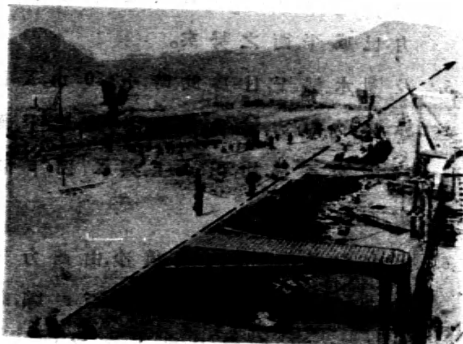
圖(五十六)同上石牆背後破壞之一斑
