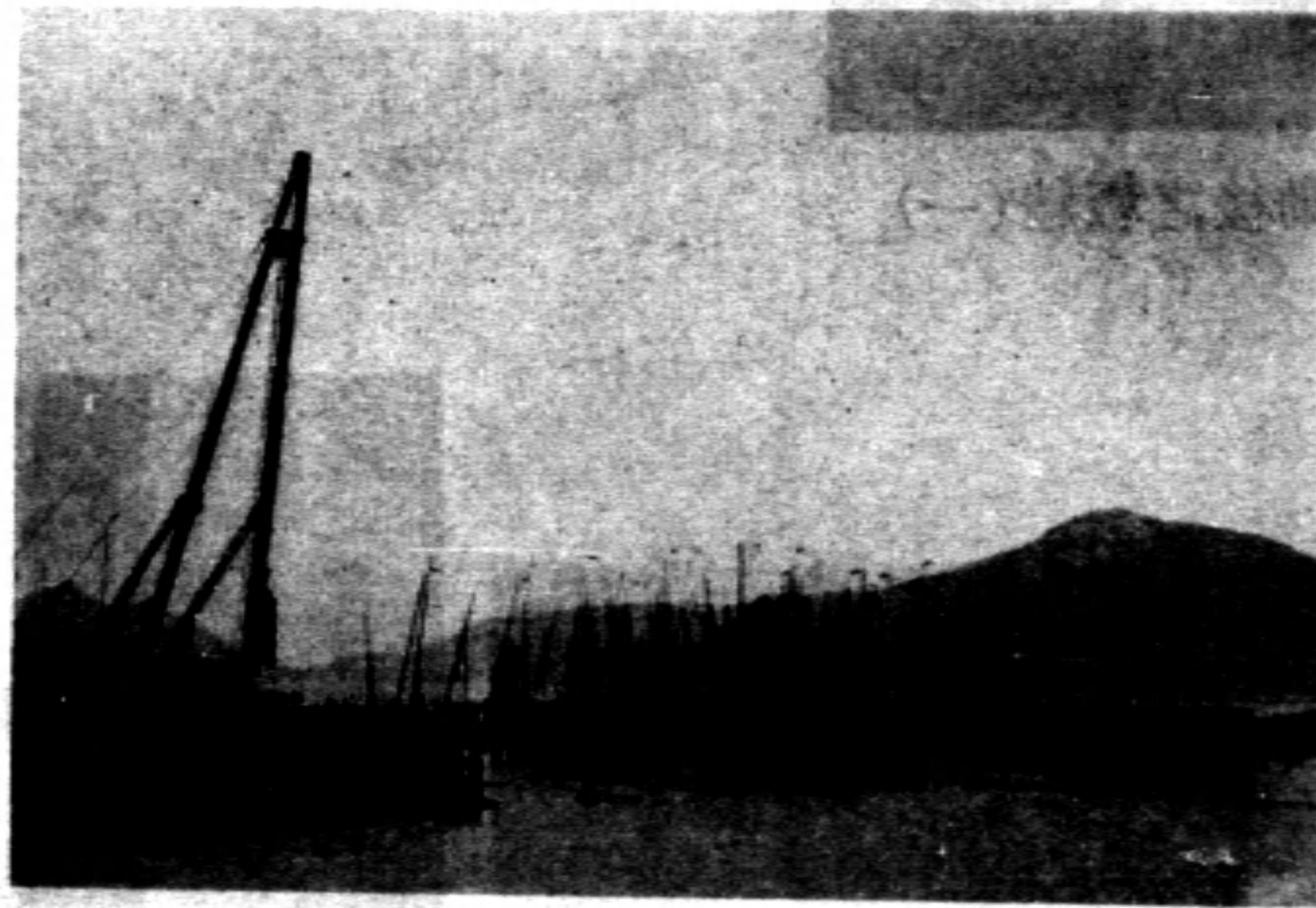
圖(二十一) 風船運沙填基溝
