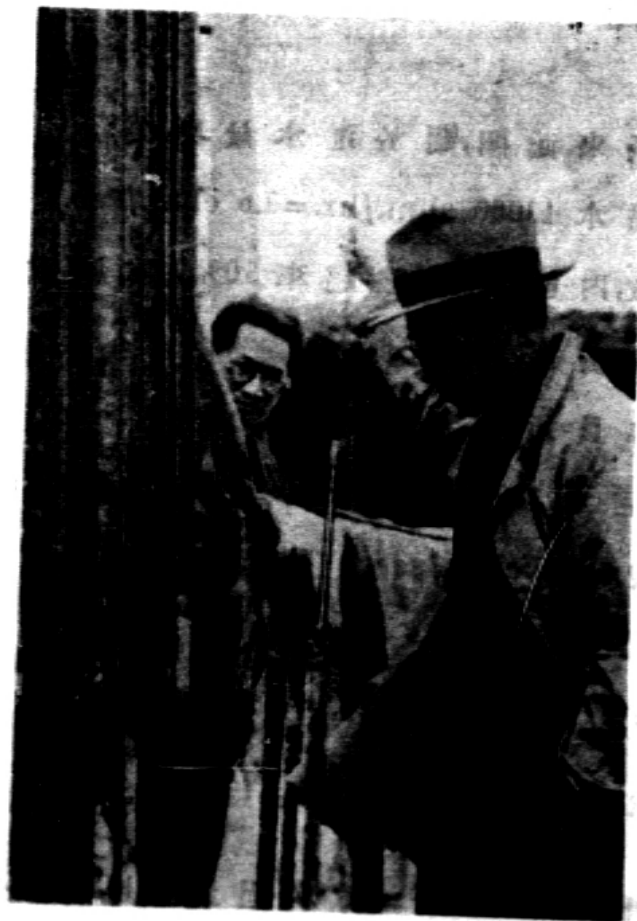
圖(七)探驗透平機躉脚核心溫度
