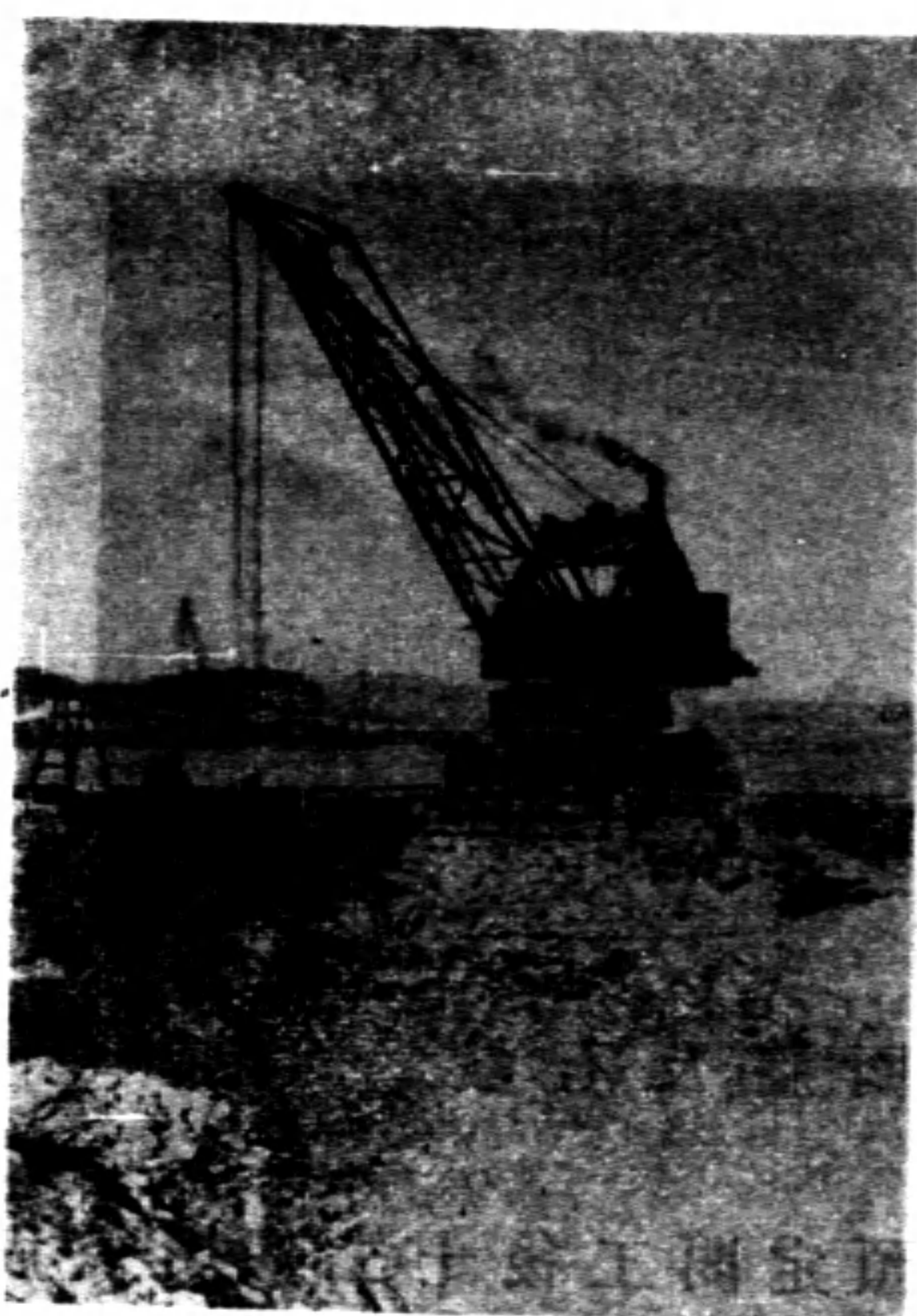
圖(三十三) 攪斗式挖泥機挖取碼頭內部軟泥工作
