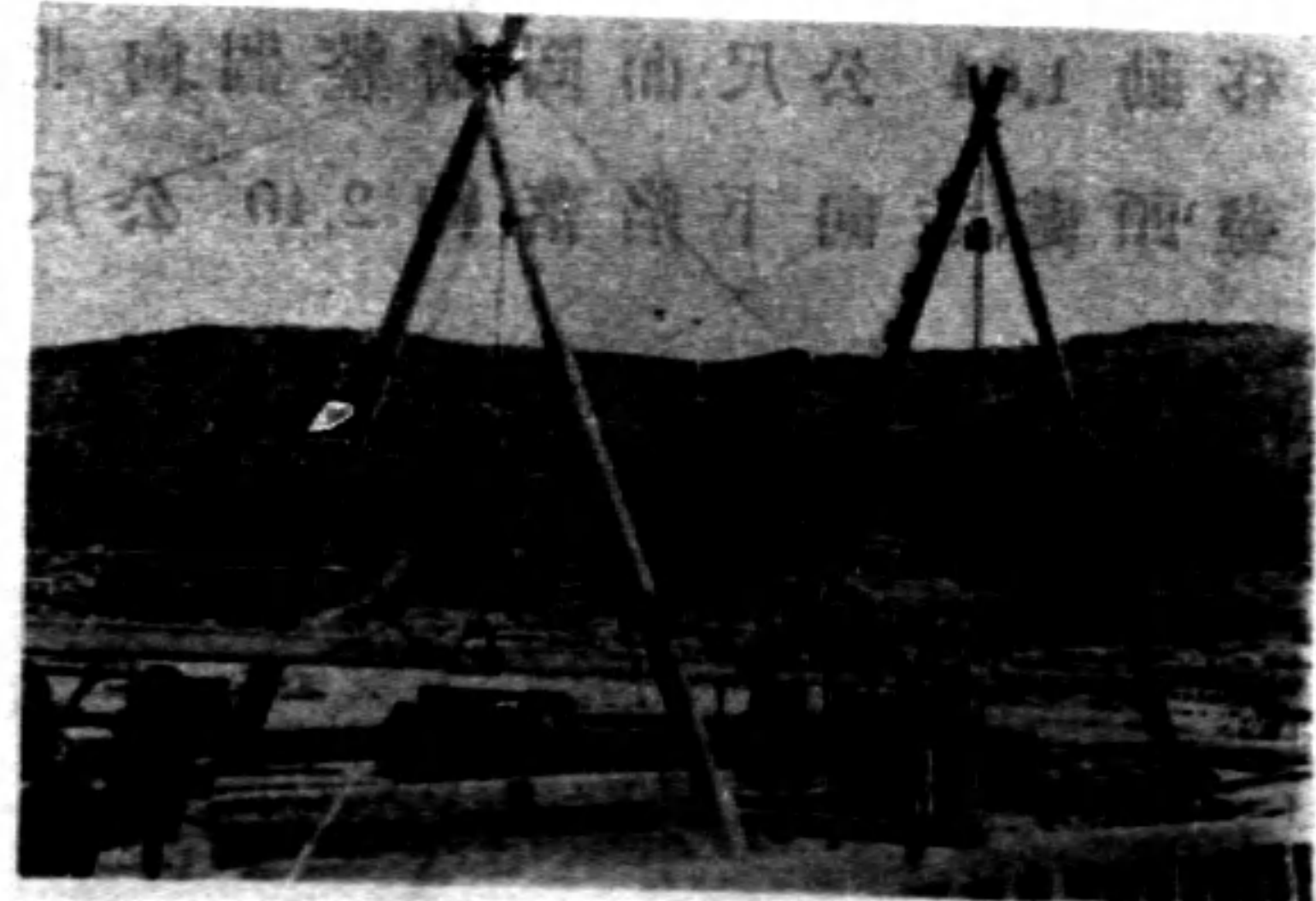
圖(三十一) 第二次失敗後拔出鋼板樁工作 圖(三十二) 矯直已曲鋼板樁工作
