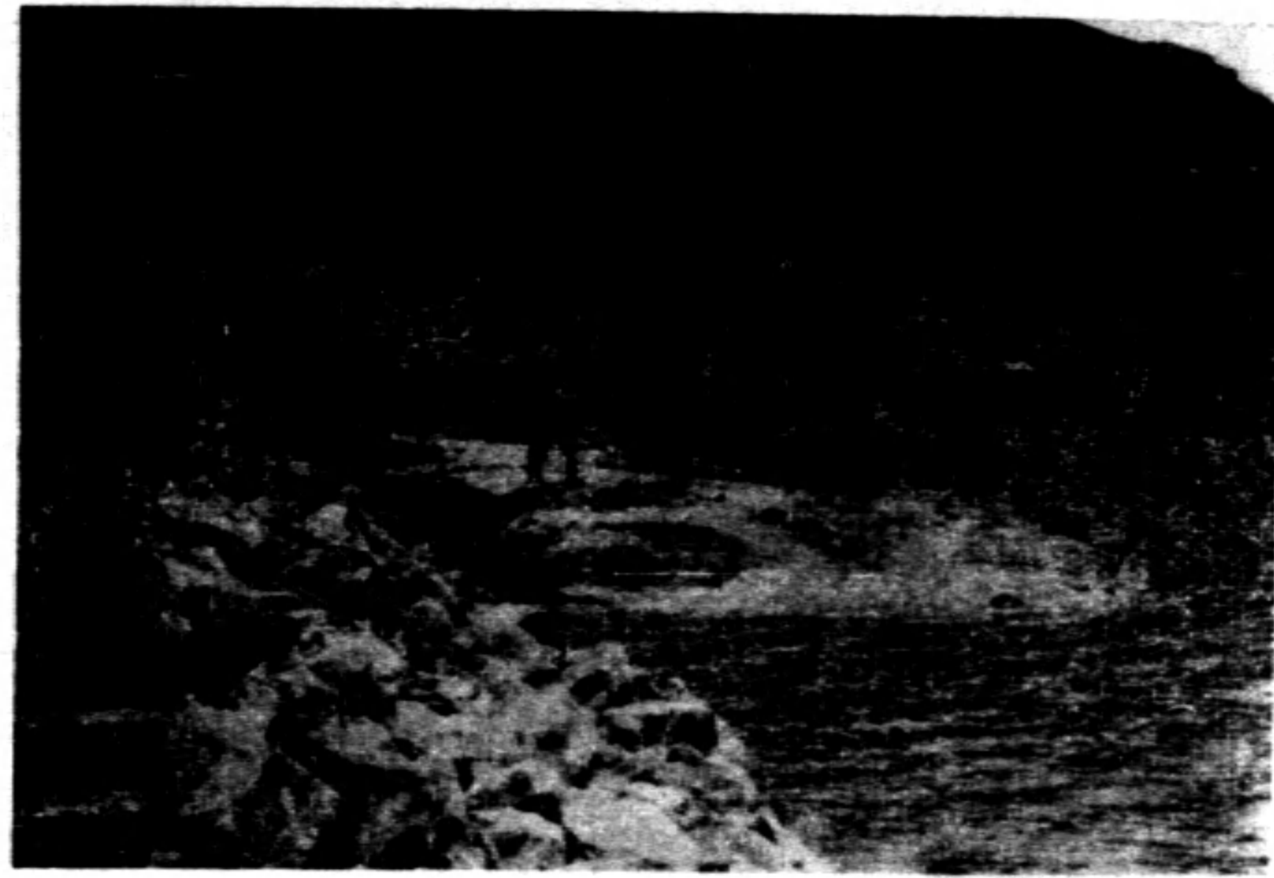
圖(五十一)外堤基溝填沙湧出後所成沙灘
