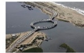
Puente de Laguna Garzón
