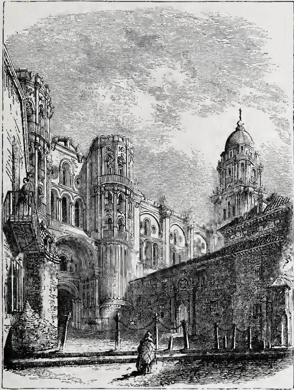
PUERTA DE LAS CADENAS, CATHEDRAL OF MALAGA.
