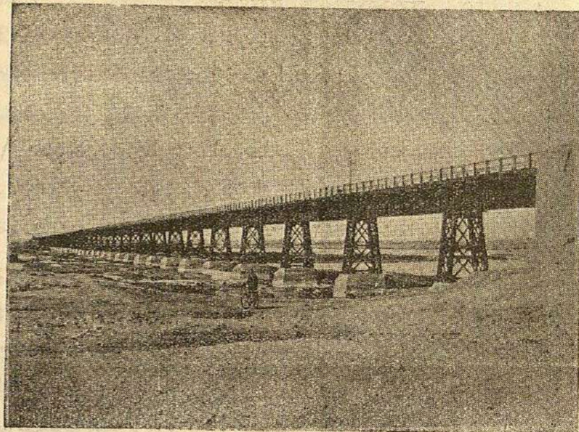
پل کارون در راه آهن اهواز
