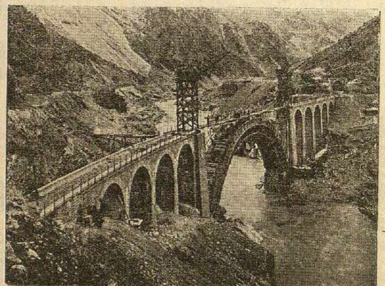
پل آبدیز بعد از اتصال طاق پل
