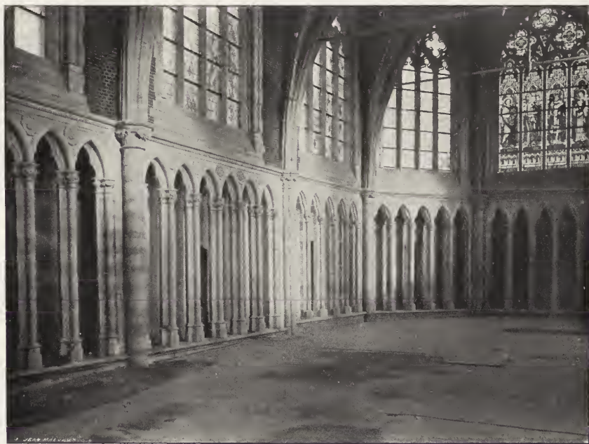
LE TRIFORIUM DU CHŒUR APRÈS SA RESTAURATION.
