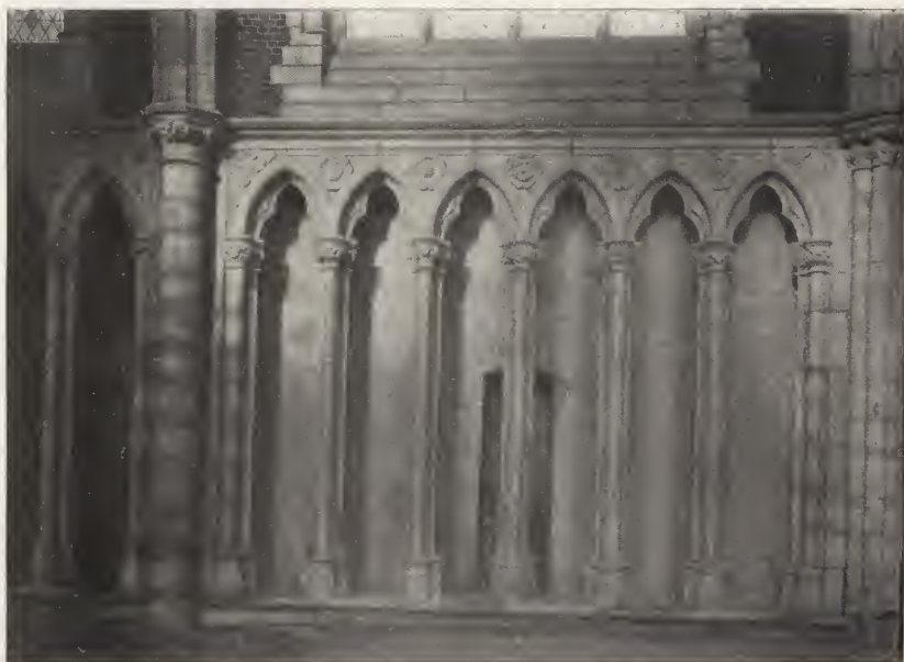
UNE TRAVÉE LATÉRALE DU TRIFORIUM DU CHŒUR APRÈS SA RESTAURATION.
