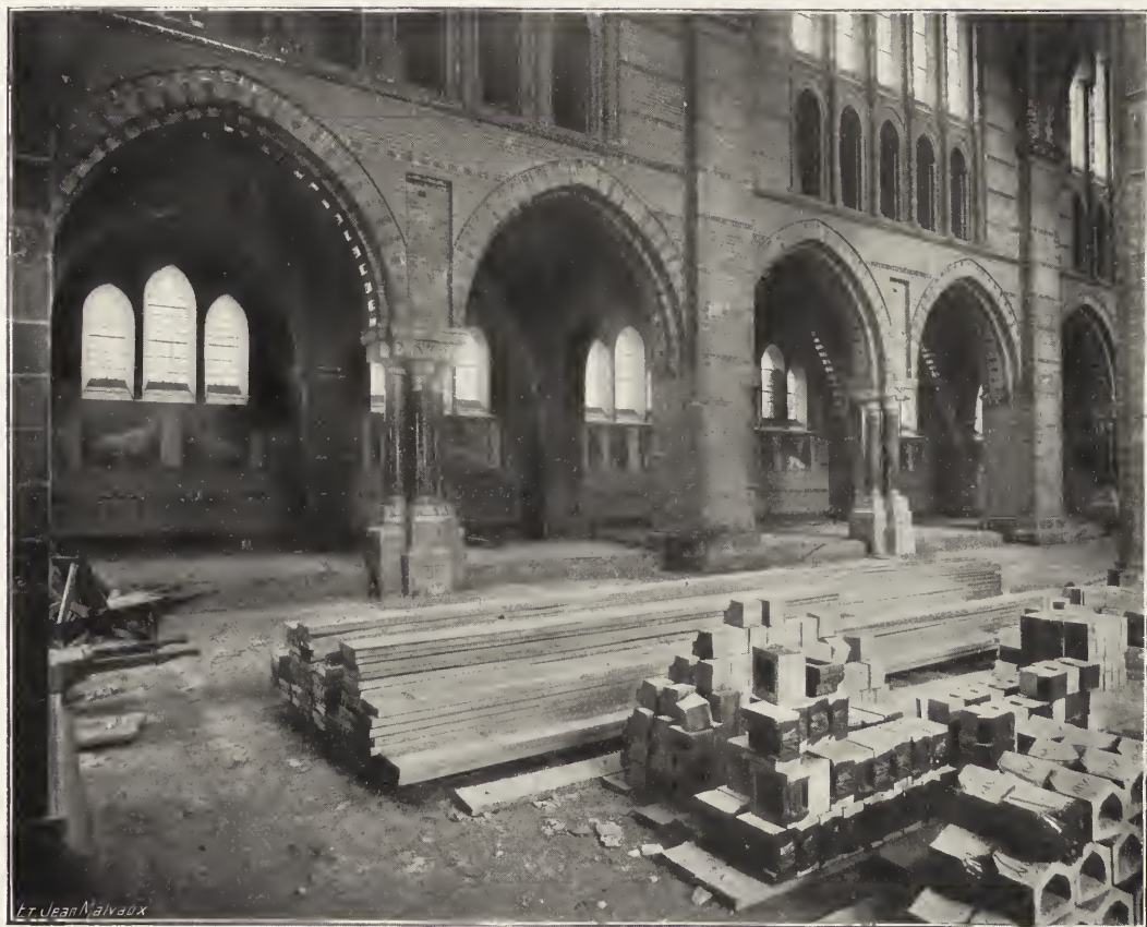
CATHÉDRALE DE HAARLEM. LE BAS-CÔTÉ NORD ET LES CHAPELLES LATÉRALES PENDANT LA CONSTRUCTION.
