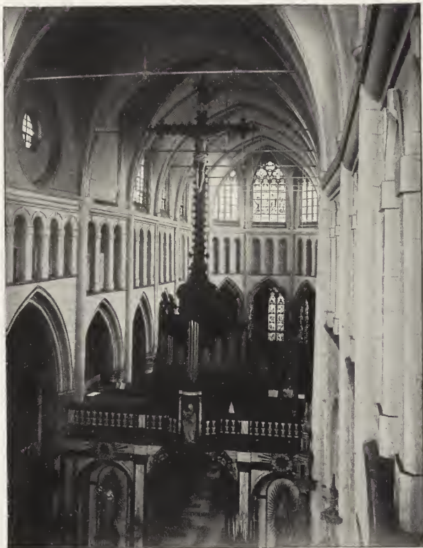
VUE INTÉRIEURE DE L'ÉGLISE NOTRE-DAME, AVANT LA RESTAURATION DU TRIFORIUM.
