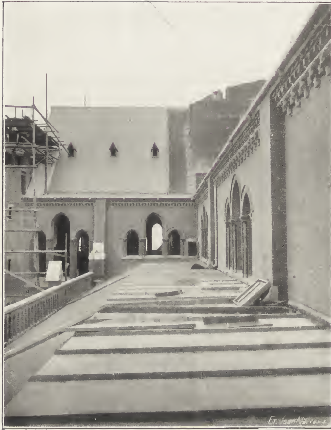
CATHÉDRALE DE HAARLEM. LA TOITURE DU BAS-CÔTÉ NORD PENDANT LA CONSTRUCTION.
