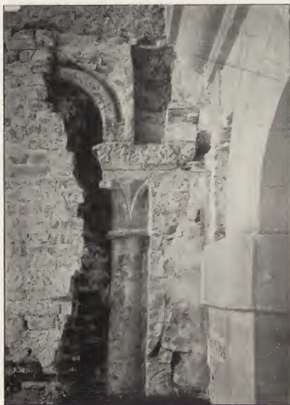
DEMI-ARCATURE RESTÉE EN PLACE DANS LE MUR OCCIDENTAL DE L'ÉGLISE.
