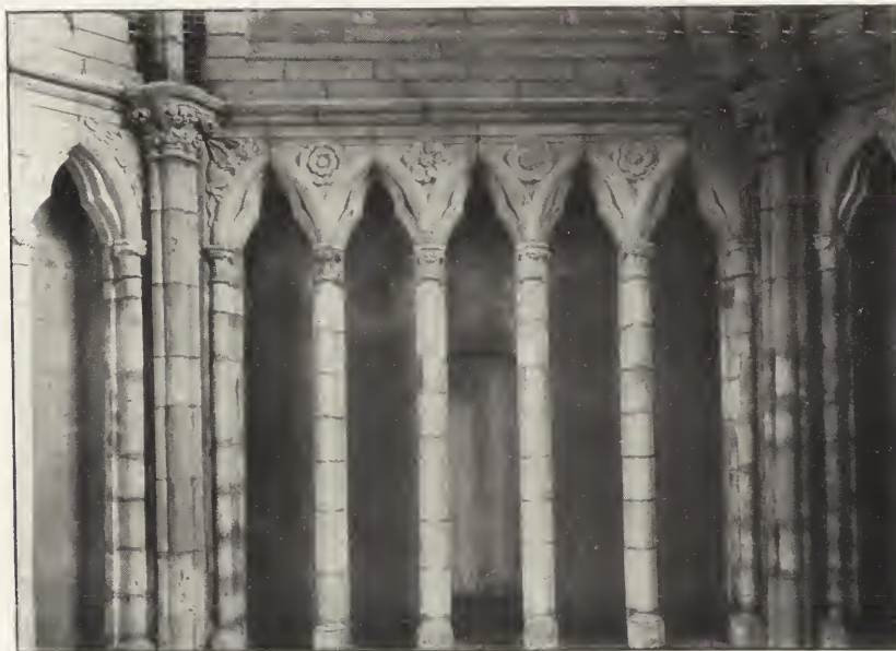
UNE TRAVÉE DU TRIFORIUM DANS L'ABSIDE APRÈS SA RESTAURATION.
