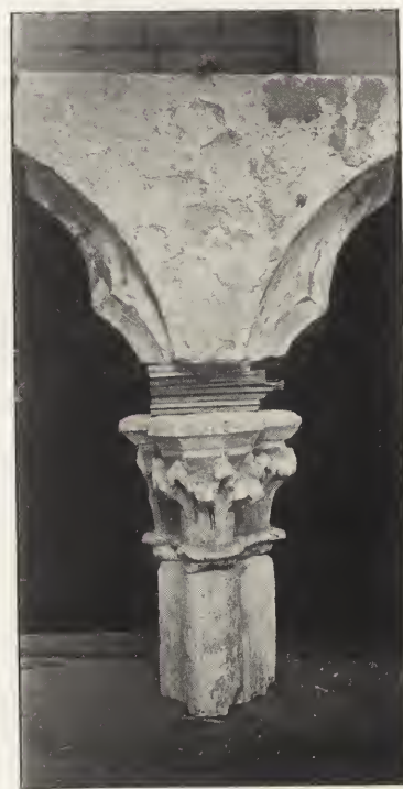
FRAGMENT D'ARCATURE EXTRAIT DE LA MAÇONNERIE DU TRIFORIUM ACTUEL.
