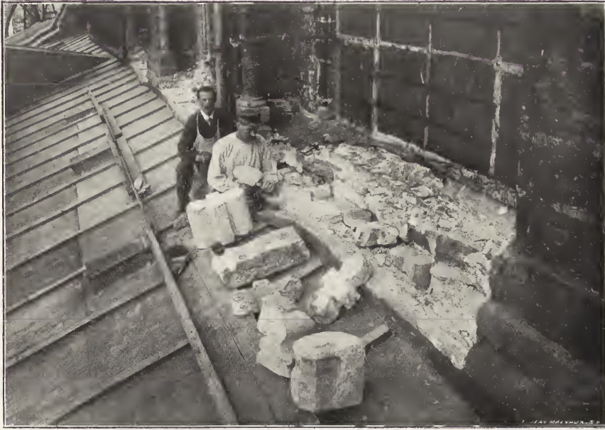
EXTRACTION DE PIERRES AUX GLACIS EXTÉRIEURS DES FENÊTRES.
