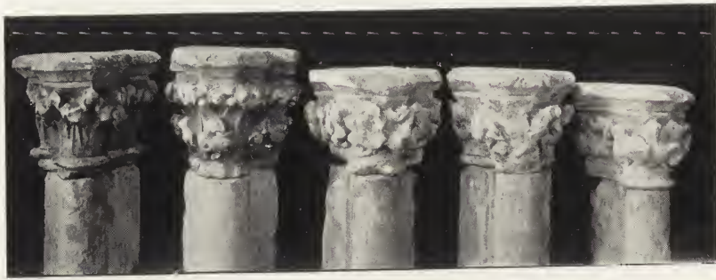
CHAPITEAUX ET BASES DÉCOUVERTS DANS LA MAÇONNERIE SOUS LES GLACIS DES FENÊTRES. FACE.
