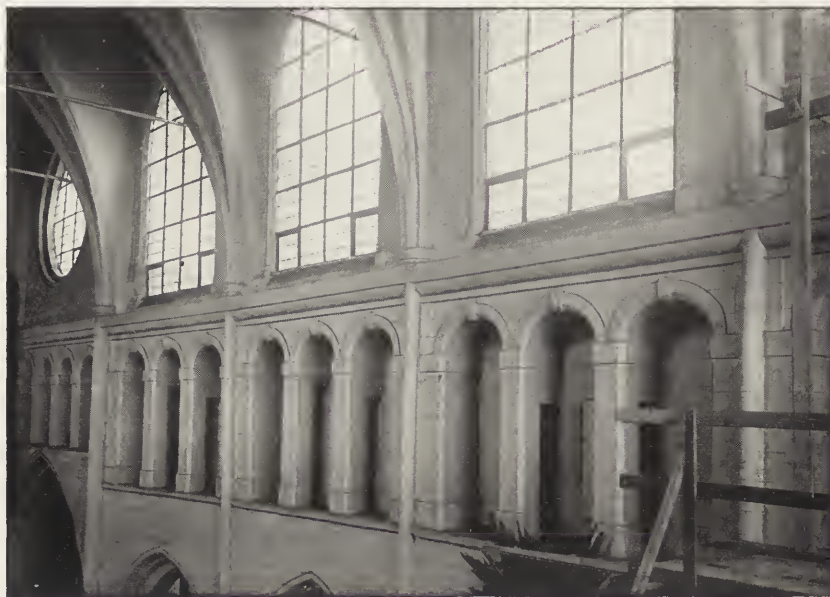
TRIFORIUM DE LA NEF, AVANT LA RESTAURATION.
