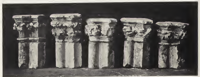
CHAPITEAUX ET BASES DÉCOUVERTS DANS LA MAÇONNERIE SOUS LES GLACIS DES FENÊTRES. PROFIL.
