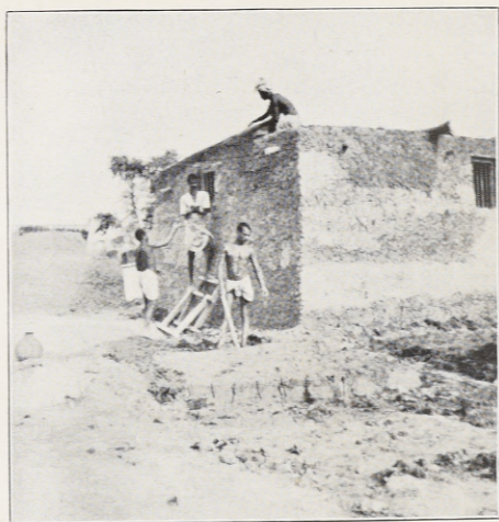
Une maison en « adobé ».
