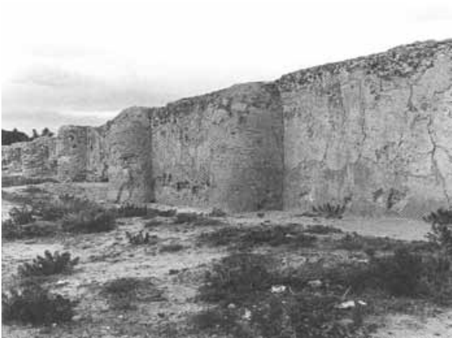
FIGURA 10.5 O grande tanque de Rakāda, nas proximidades de Kayrawān; os enormes contrafortes quebram as ondas provocadas pelo vento. [Fonte: Instituto Nacional de Arqueologia e Arte, Túnis.]
