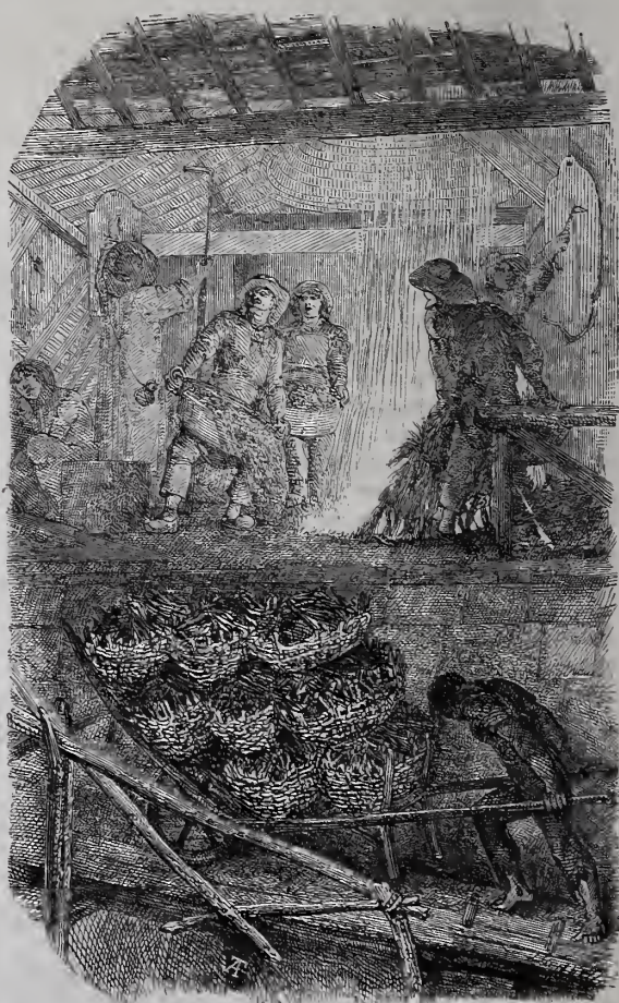
Chargement du minerai et du charbon au gueulard.
