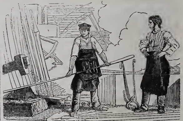
Fabrication du petit fer au martinet.
