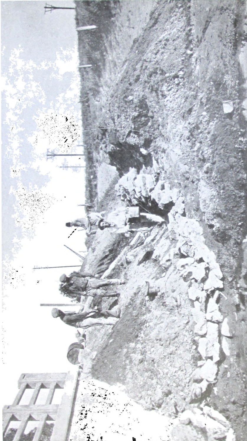
Vista N.º 11. — Ejecutando el revestimiento del talud de la obra de las vistas números 7, 8, 9 y 10 con piedras cimentadas.
