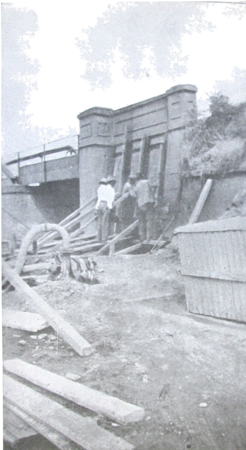
Colocación del anclaje en el muro de ala del puente Las Garzas.
