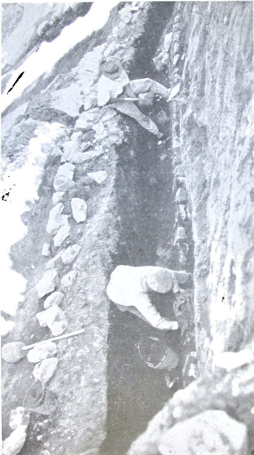
Vista N° 10. — Cimentando el muro de sostén descrito en la vista N° 9.
