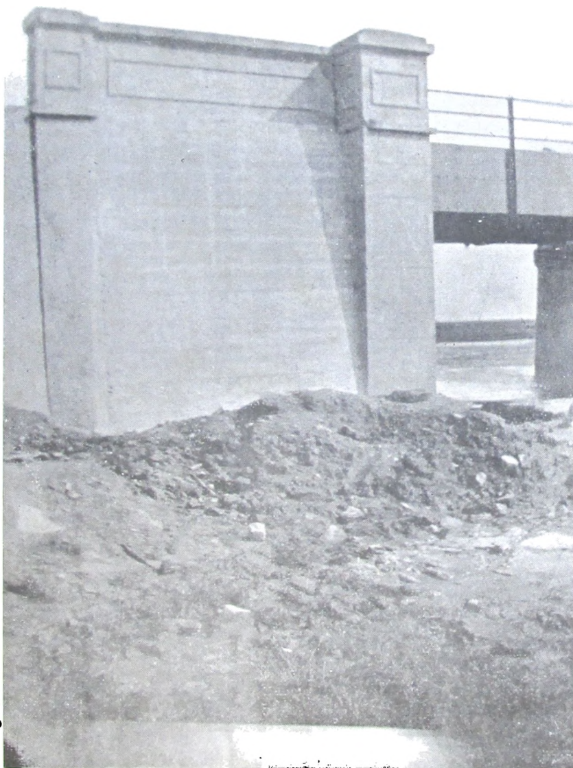
Muros de ala reparados del puente Las Garzas.
