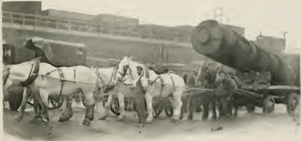
CARTING A BIG BOILER, L. AND N. W. R.
