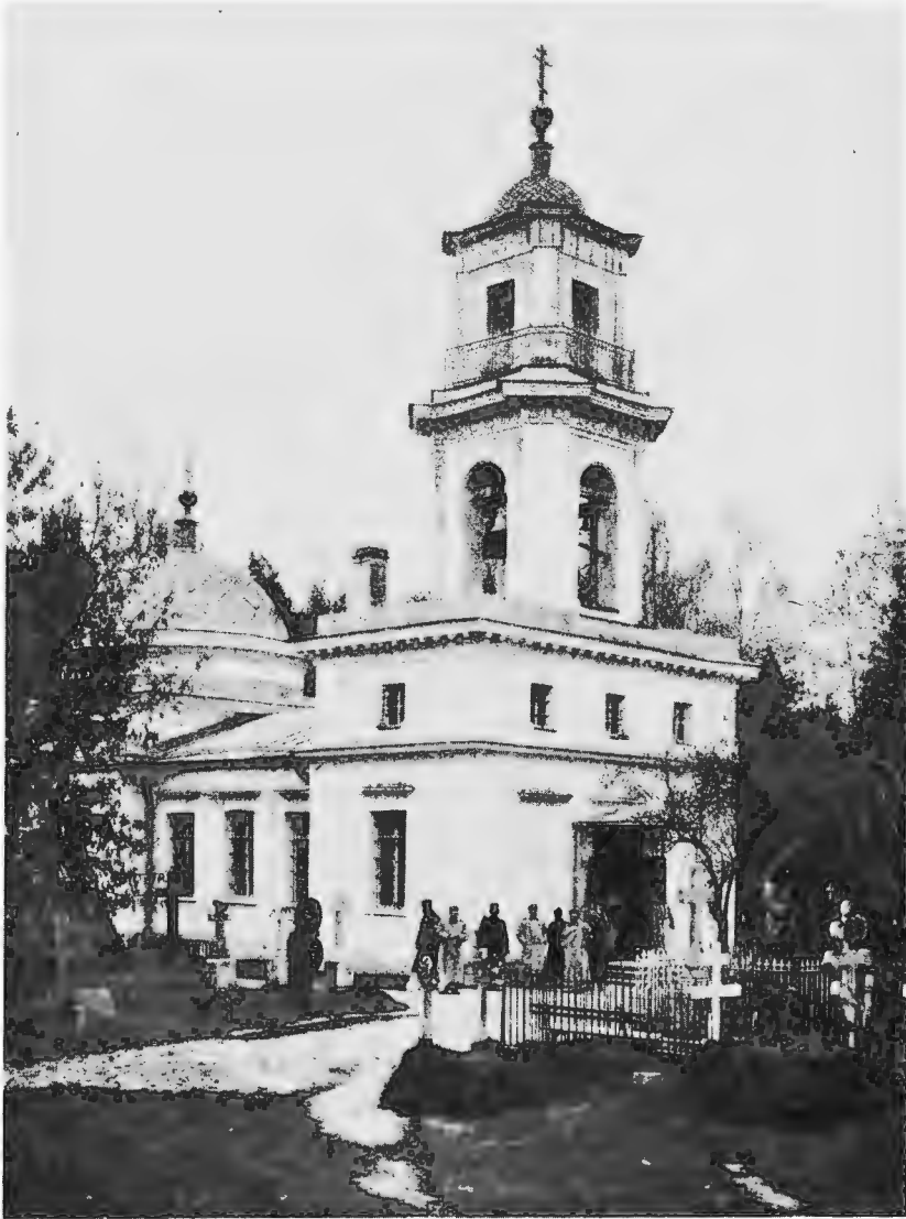
Церковь на Шлиссельбургскомъ кладбищѣ.
